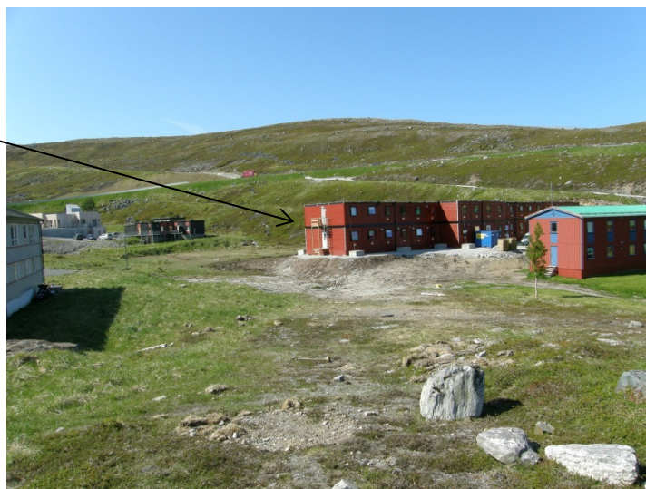
Del av midlertidig brakkerigg øst for Skytterhuset. Arealet denne står på vil inngå i barnehagens uteområde.
