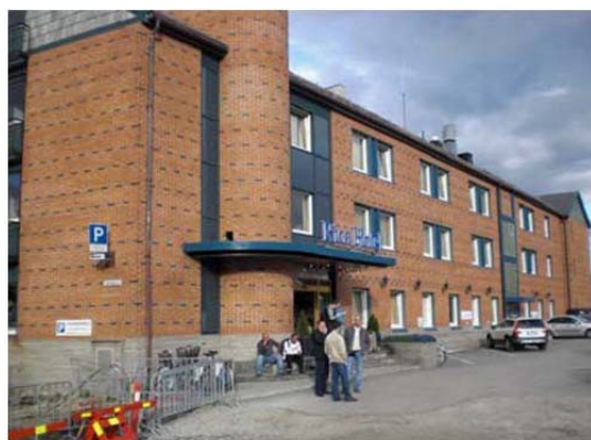
Vestsiden av Batteriet, sett nordvestover.
