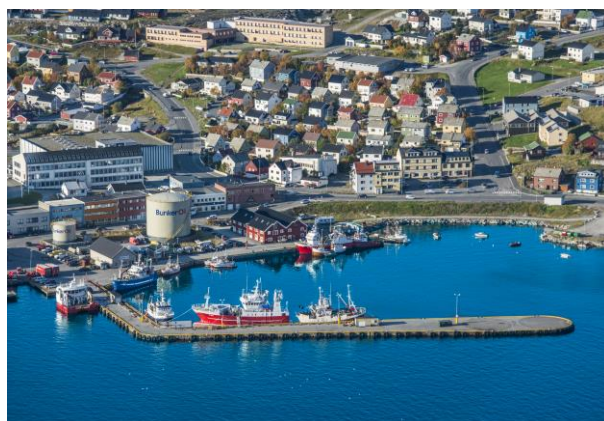
Oppgradering av kaier og kaiarealer på Fuglenes Fotorettigheter: Hammerfest Havn KF.
