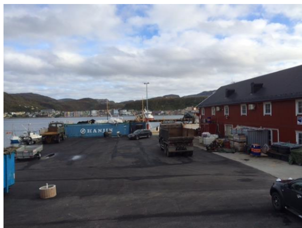
Oppgradering av kaier og kaiarealer på Fuglenes. Foto: Hammerfest Havn KF.
