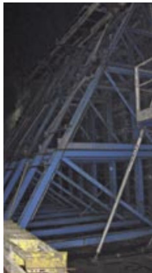
Spesialforskaling ved støping mot fjell (ensidig forskaling) på grunn av høye vegger.
