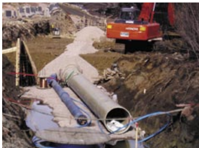
Groft med rørlegging- oversikt
