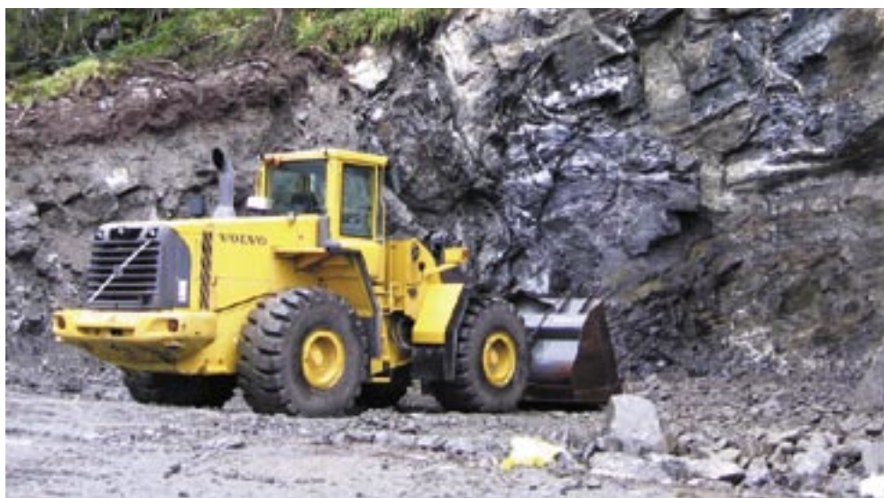
Anleggsmaskin ved oppstart anlegget for nesten ett år siden.
