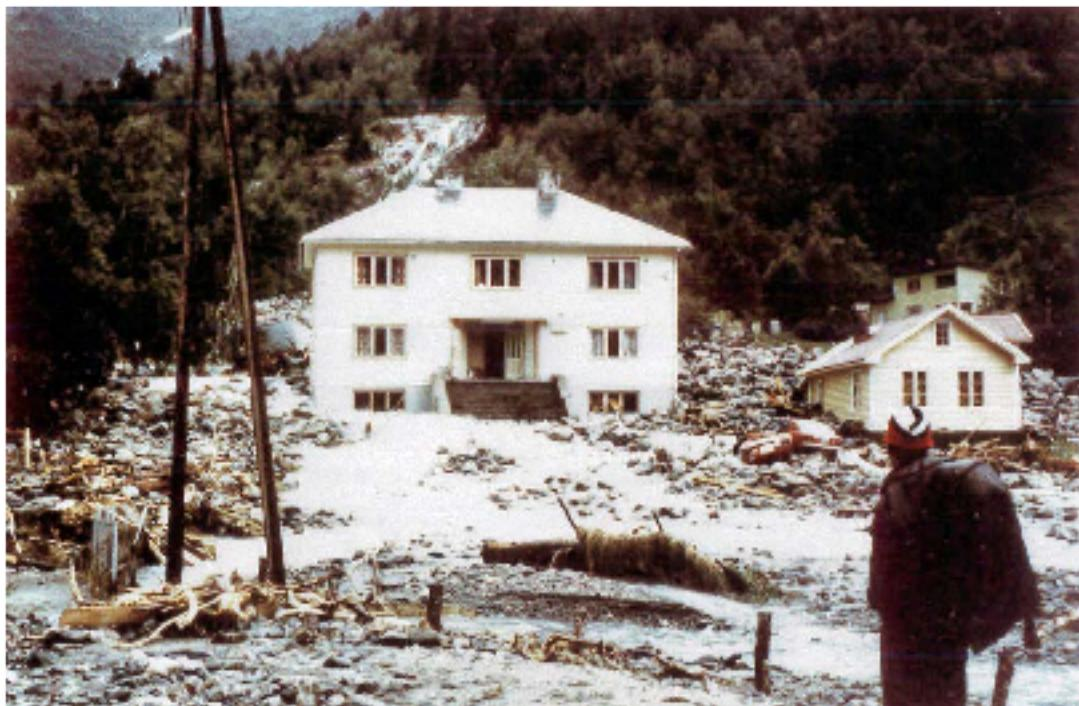
Figur 35. Jostedal herredshus på Sagerøy etter flomskredet i august 1979. Flere mindre bygninger ble rasert, biler ødelagt og kjelleren på herredshuset ble oppfylt med stein. Sagerøyelva hadde tatt nytt løp over svabergen i bakgrunnen. Foto fra NGI-rapport 79498
