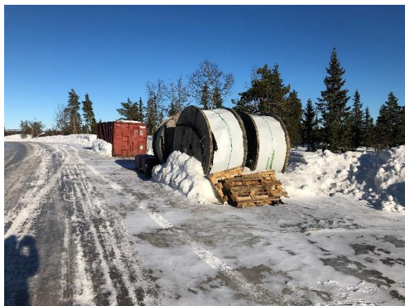
Kabeltromler på Hamarsætra
