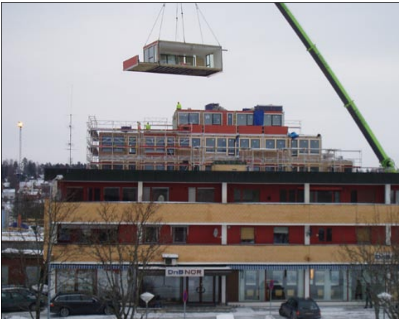
Bygging av leiligheter i Ås sentrum. (Foto: Johan Alnes)
