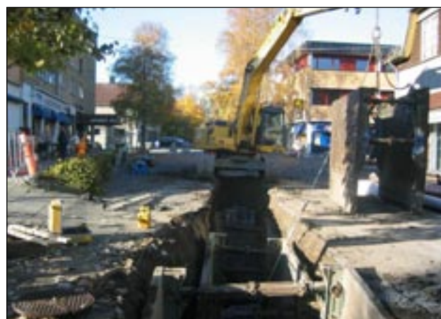
Nye avløpsrør i Ås sentrum (Foto: Ås kommune)
