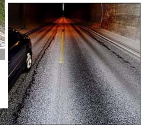
SPORET: Her i Hellbunnelen er det 3 028 meter sporetunnel. På grunn av den høye prisen på olje i Norge og andre land, får ikke Norge råd til å legge nytt asfaltdøkke her. Foto: Øyvind Nordahl Næss
