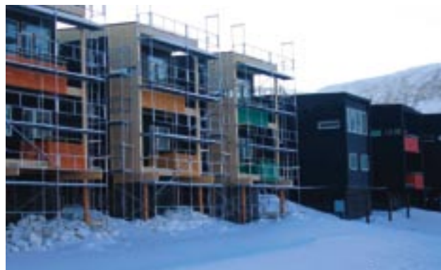
Utbyggingen i Gruvedalen har fortsatt gjennom hele 2004. I selve Gruvedalen ble 37 boenheter ferdigstilt i løpet av 2004. Totalt i hele Longyearbyen ble det i 2004 ferdigstilt 38 boenheter (alle byggemeldt i 2003), mens 19 boenheter er byggemeldt i 2004, og påregnes ferdigstilt i løpet av 2005. Foto: Turid Telebond
