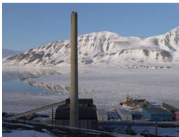
I statsbudsjettet for 2006 legges det opp til at reservekraft og reserve vannforsyning skal brukerfinansieres. På bildet ser vi kraftstasjonen i Longyearbyen med den rundt 90 meter høye pipa. Foto: Mari Tefre
