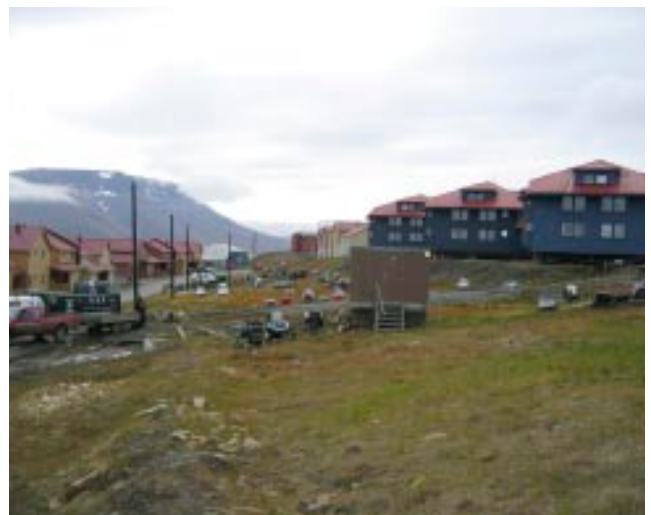
Fortetting innebærer bygging på ledige arealer. Bygging av hybelhus i vei 234 skapte frisk debatt! Foto: Vigdis Hole
