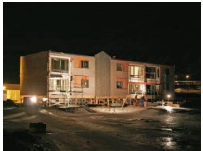
De siste årene har det vært stor aktivitet i forbindelse med husbygging i Longyearbyen. I løpet av 2006 har det kommet bebyggelse til bolig- og næringsformål på Elvesletta nord. Foto: Birger Amundsen, Svalbardposten
