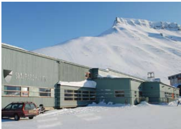
Svalbardhallen er godt besøkt. I 2007 ble den utvidet med nytt tilbygg som bl.a. gir plass til flere treningsrom og nytt kjøkken. Samtidig er det installert nytt og tidsmessig adgangssystem. Foto: Kåre Hovland
