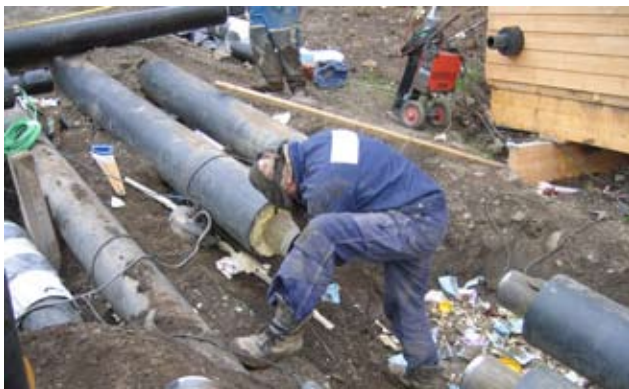
Boliger i Longyearbyen er tilknyttet fjernvarme. Her legges rør til et nytt bygg i Vei 234. Foto: Lene Pedersen
