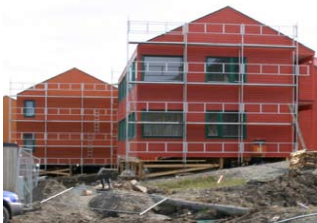
Det var etterspørsel etter boliger og byggeaktiviteten er stor både innenfor næringsbygg og boliger. Det har ført til fortetting i boligområdene, som her i Vei 234.
