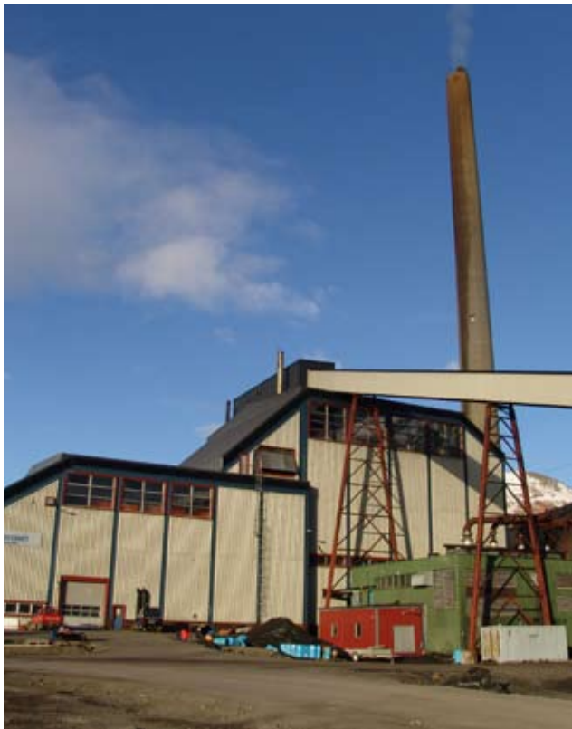
I 2007 har energiverket gjennomført en komplett revisjon av turbin 1. Foto: Mari Tefre
