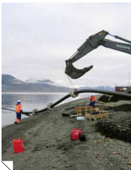
Det er lagt ut ny utslippsledning i Adventsfjorden. Foto: Håkan Eriksson
