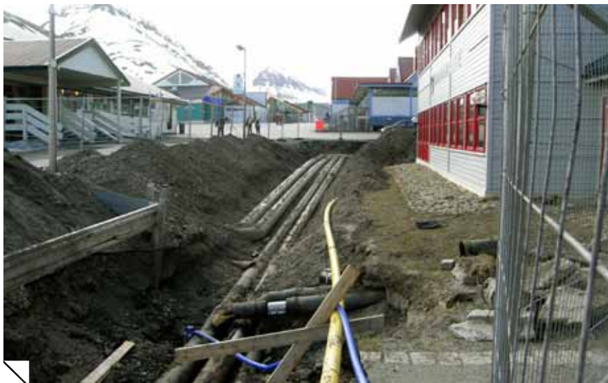
Fjernvarmenettet ved Næringsbygget hadde sunket og ble skiftet ut. Foto: Anne Lise Olsen
