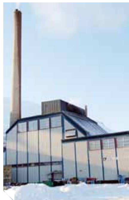
Longyear Energiverk er landets eneste kullfyrte kraftvarmeverk. Foto: Brynjulv Øverby
