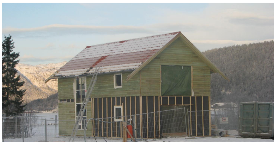
Nytt avløpsrenseanlegg på Bjerka under bygging
