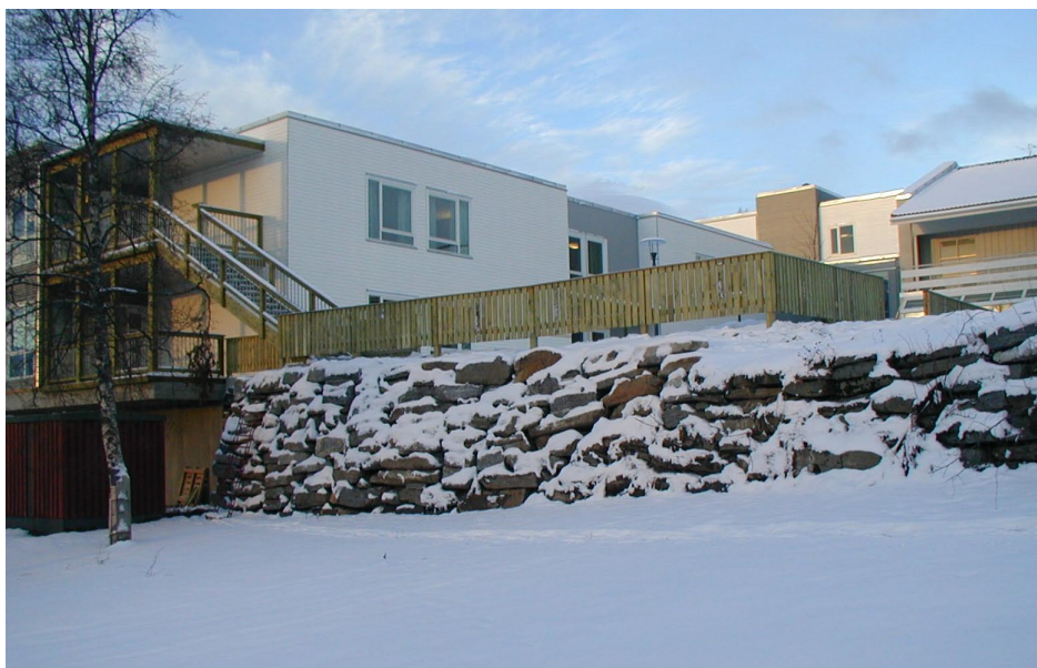
Det nye omsorgssenteret på Hemnesberget
