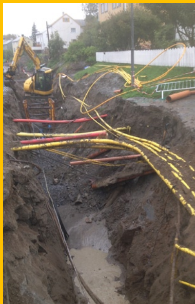
Fra renoveringen i Parkvegen. Arbeidene her var spesielt utfordrende på grunn av svært mye kabler.
