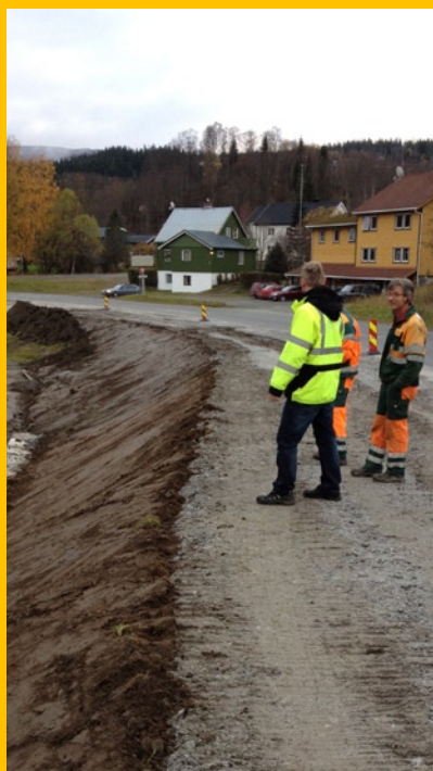
I 2013 ble det laget fortau mellom rådhuset og Samfunnshuset. Prosjektet ble finansiert med tilskuddsmidler fra "Åksjon skolevei"
