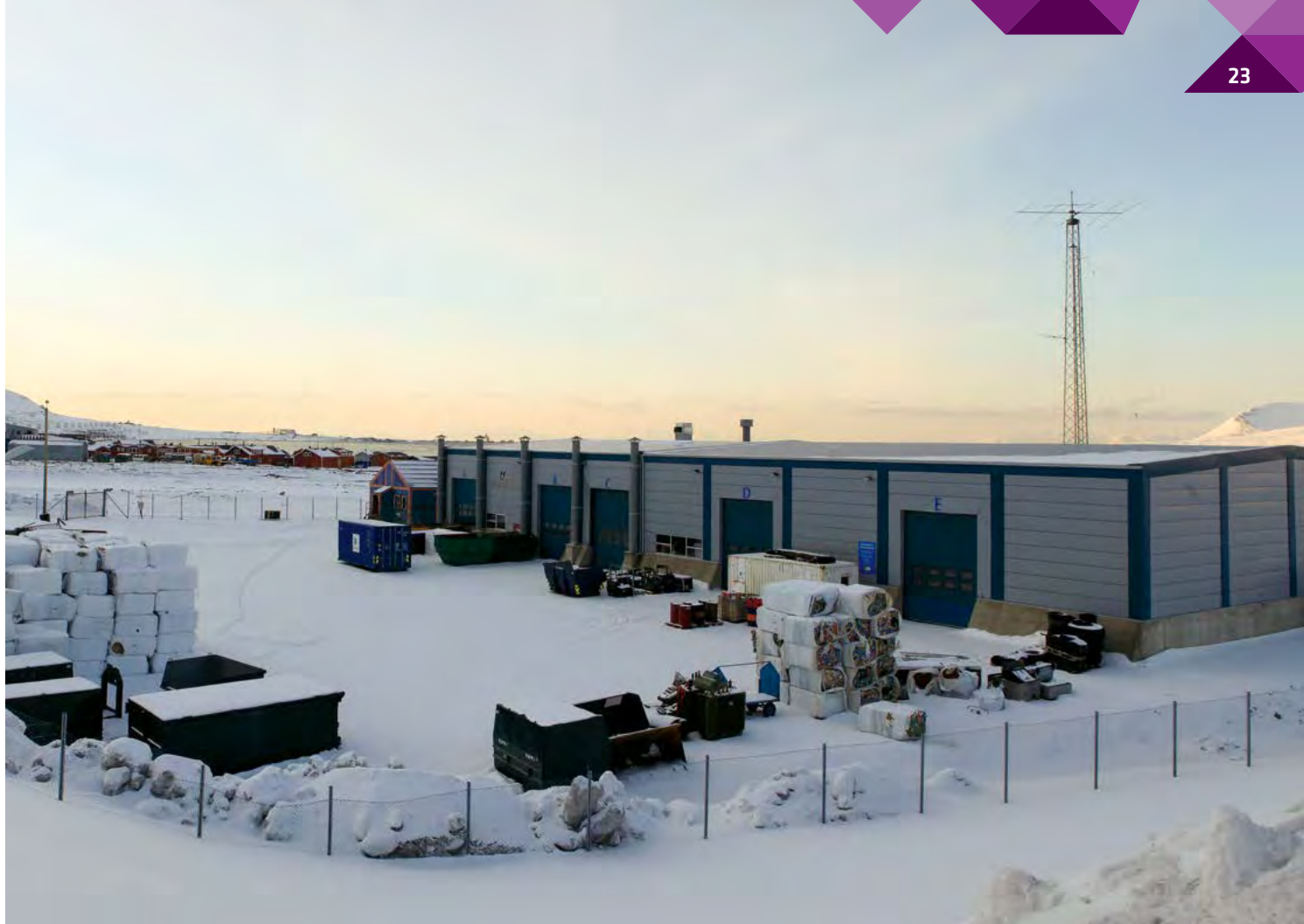
Eksisterende avfallsanlegg er kapasitetsmessig ikke tilpasset dagens avfallshåndtering. Foto: Grete R. Haldorsen.
