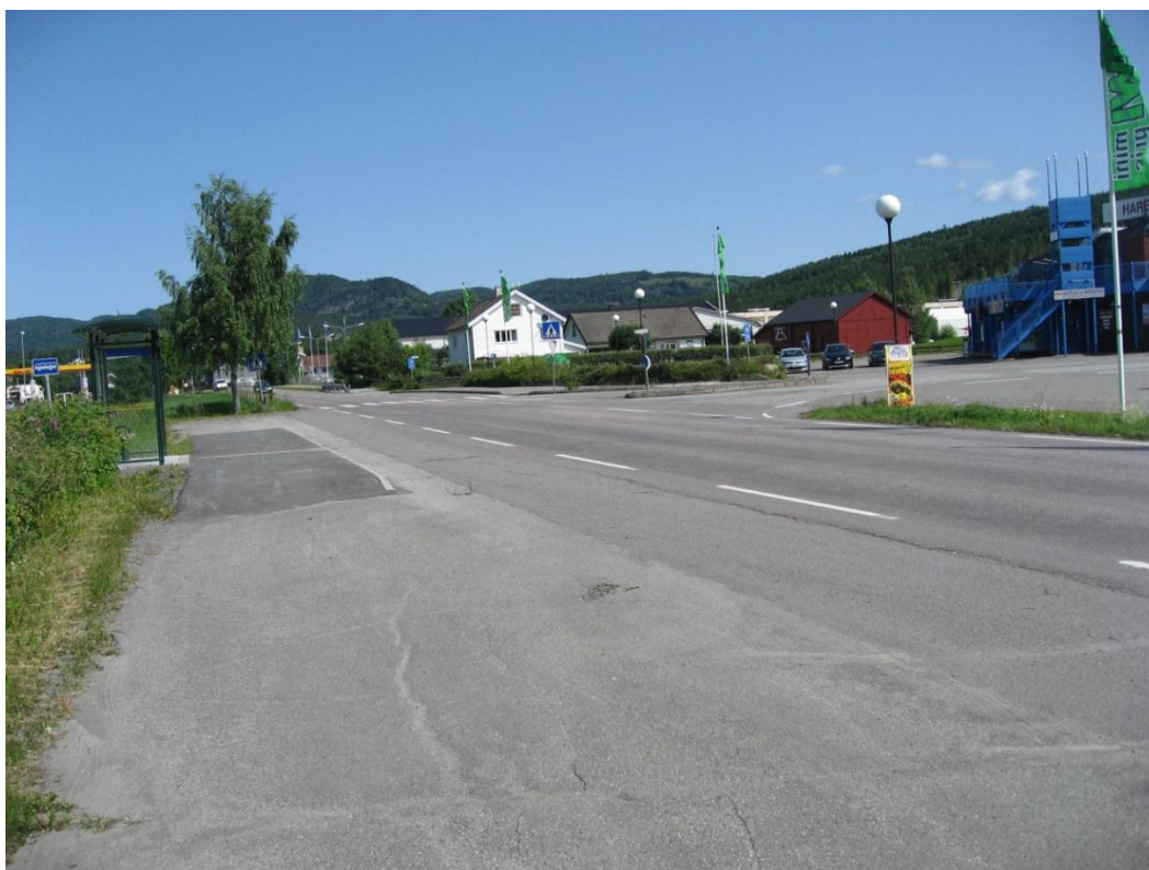
Ill. 8. Fra Hadelandsveien sett nordover. Eksisterende innkjøring.
