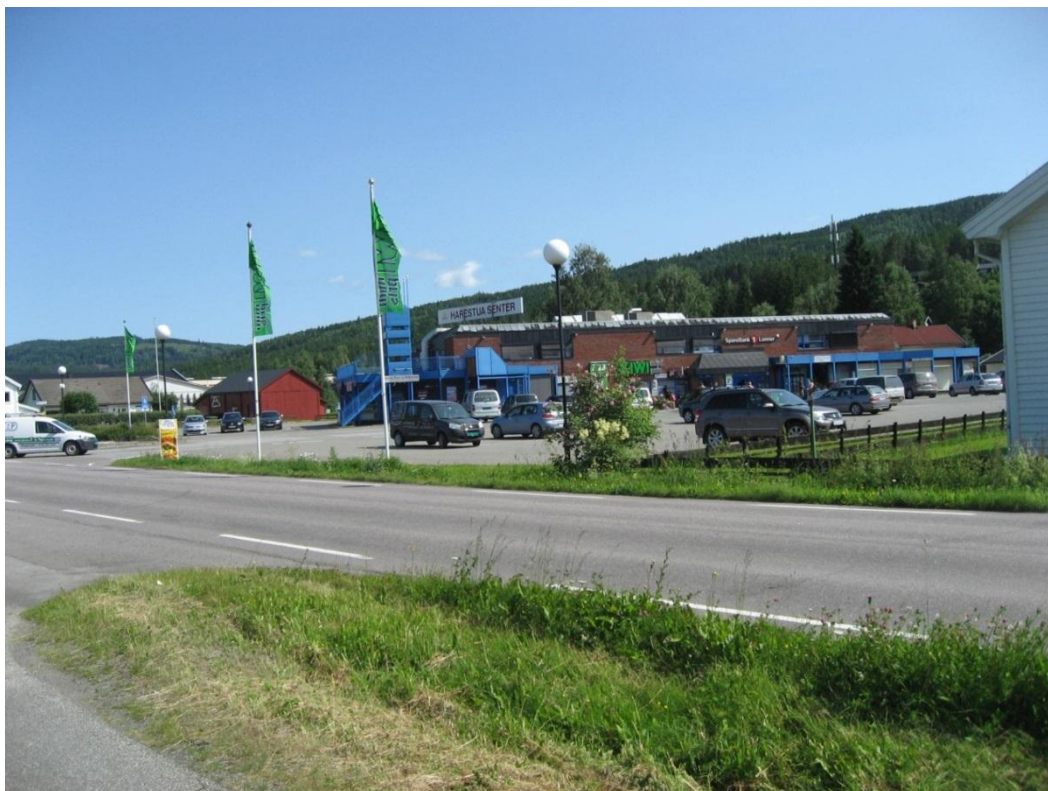
Ill. 7. Dagens situasjon, fra Hadelandsveien sett nordøstover
