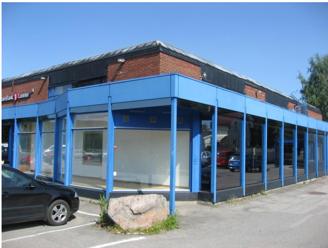
Ill. 12. Kiwi-senteret, eksisterende fasadeuttrykk
