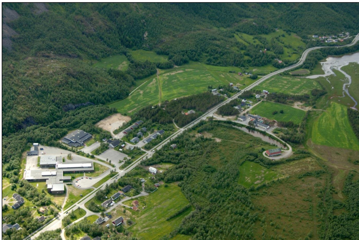
Figur 8: Skråfoto som viser planområdet til høyre for E6.
