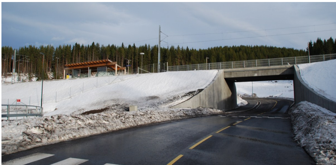
Figur 2-18. Harestua holdeplass med kulvert under Gjøvikbanen
