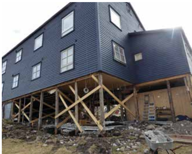
Utskifting av peler. Foto: Elin Dolmseth
