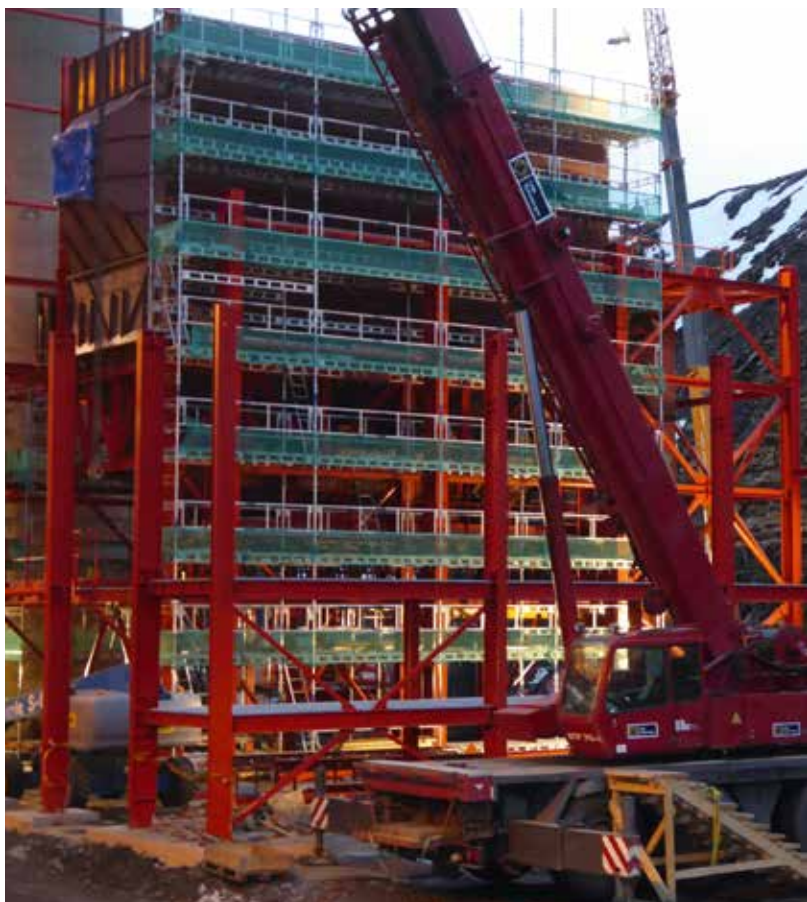
Røykgassanlegget på energiverket under bygging. Foto: Elin Dolmseth
