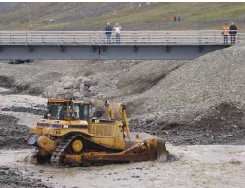
Dosing ved nybrua på Museumsveien. Foto: Elin Dolmseth
