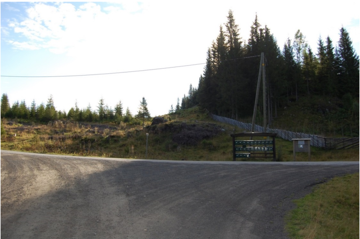
Fig. 4.8 Fra krysset med Vollavegen. Nordstrandkollen til høyre. Nærmeste terreng her vil bli senket noe, til høyde med Sveavegen.
