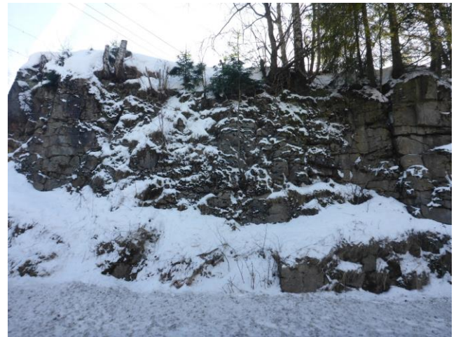
Østre fjellskjæring sør for tunnelen.
