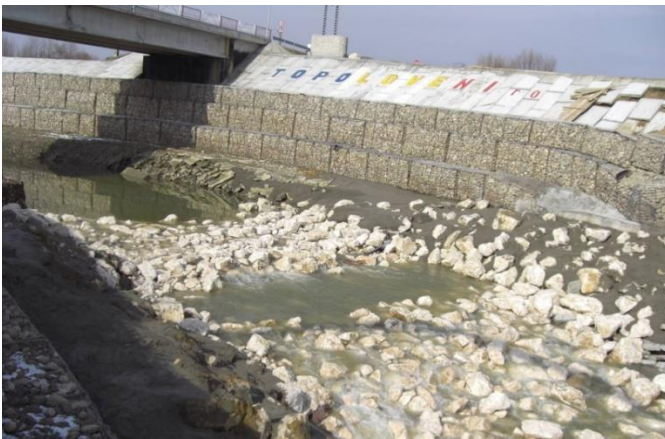
Figur 23. Erosjonssikring med gabioner (Corrinna Wendeler, Geobrugg AG).
