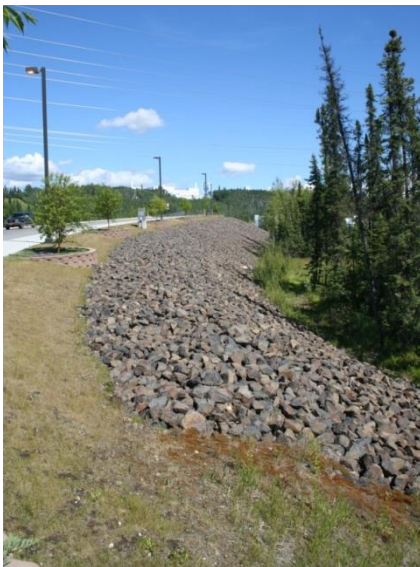
Figur 19. Ventilert fylling på hovedveg i Fairbanks Alaska som ved bruk av grovt steinmateriale oppnår konveksjon i vinterhalvåret bevarer permafrosten i vegfyllinga. (Illustrasjon av Professor Douglas Goering, University of Alaska Fairbanks UAF).
