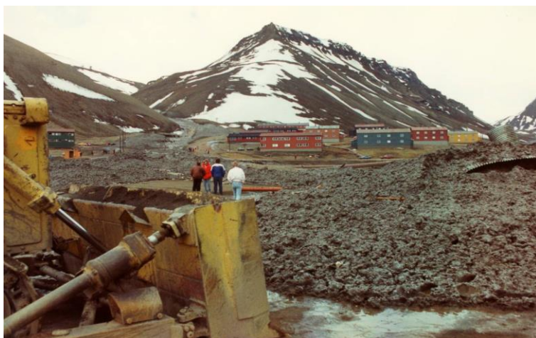
Figur 45. Sørpeskredet på Haugen i Longyearbyen i juni 1989 som følge av at tiltaket med bulldosere ikke ble gjennomført som planlagt (foto fra SNSK-arkiv).
