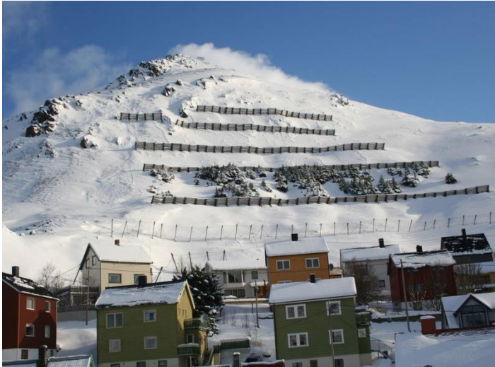
Figur 30. Forbygninger i Stål og tømmer i Honningsvåg for å sikre bebyggelsen som ligger tett opp til fjellsiden og som har hatt flere skredskader.
