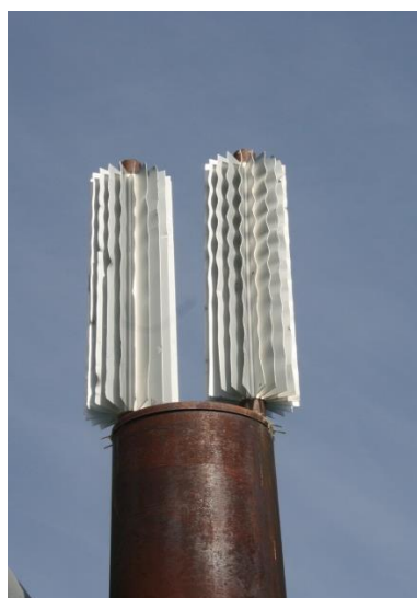
Figur 15. Prinsippskisse av et kjøleelement der en væske i et lukket system trekker varme ut av grunnen ved fordamping under klimaet i permafrosten og kondensasjon gjennom en stor fjærformet toppsegment mot kald luft (tegning fra Anatoly Sinitsyn, UNIS, foto J. O. Larsen).
