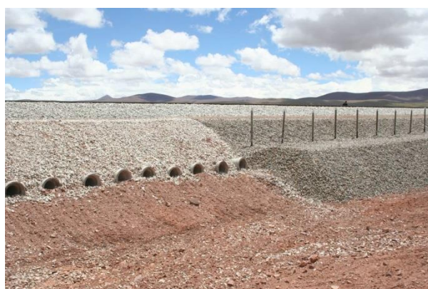
Figur 16. Jernbanen til Lasa i Tibet er lagt på høy og steinfylling med kunstig kjøling på thermosyphons og ventilasjons rør gjennom fyllinga (foto J. O. Larsen).
