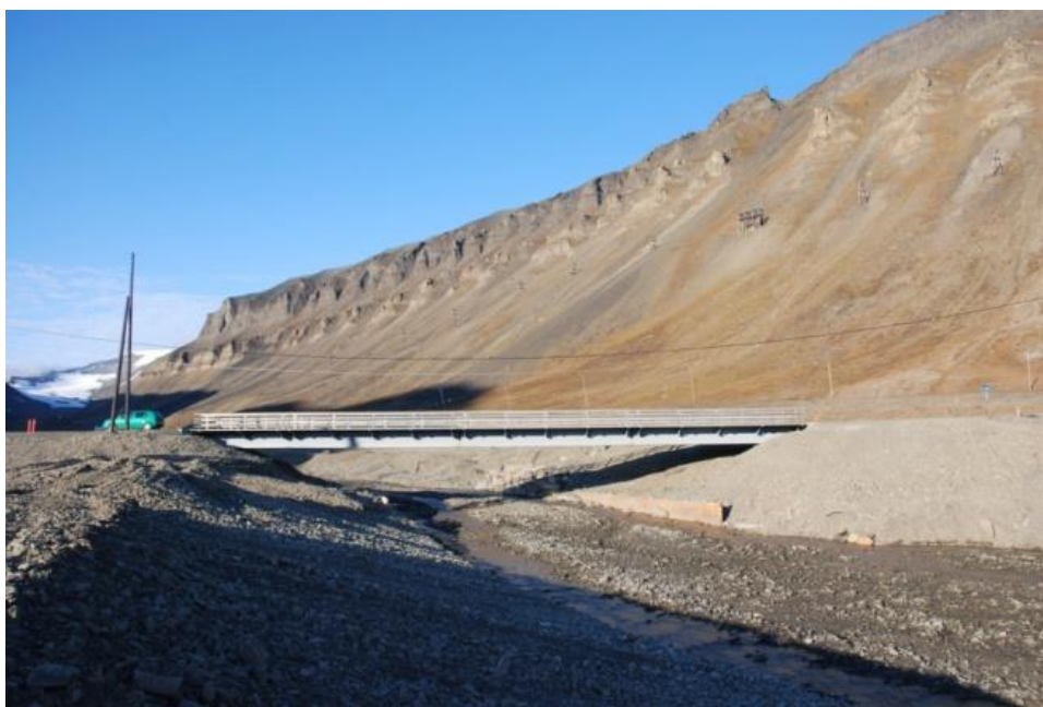
Figur 9. Stålbjelkebrua på landkar i betong forankret med stålpeler i permafrost ved et elveleie der det kan være omfattende erosjon på grunn av flom som kan påføre fundamentene skader ved opptining av permafrosten (foto J. O. Larsen).
