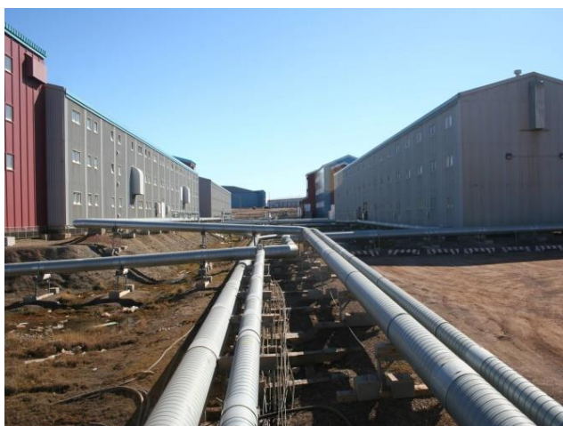
Figur 11. Infrastruktur på US Airbase Thule på Grønland der bygningene er lagt på en 1,5 m dyp gruspute på marka, mens alle rørledninger ligger på peler (foto J. O. Larsen).
