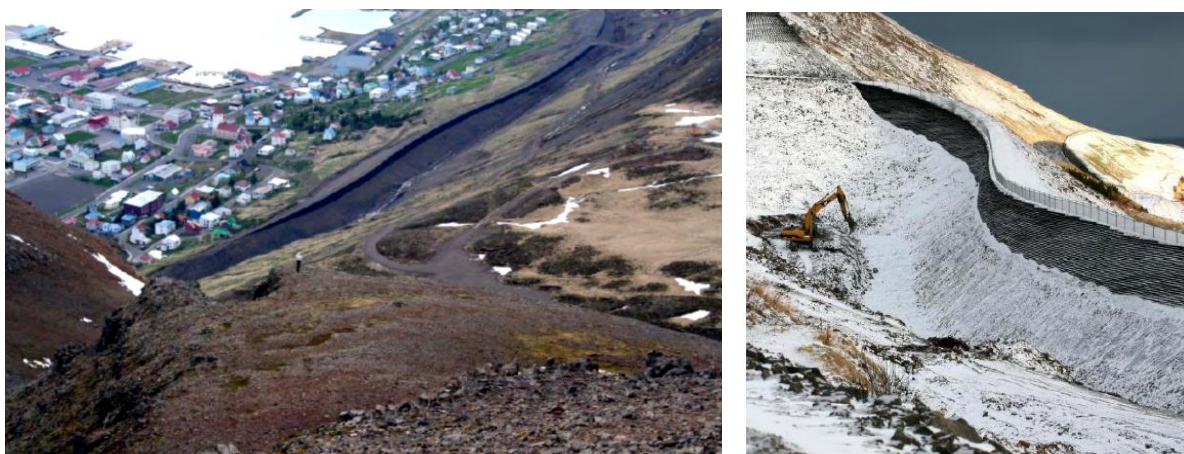
Figur 43. Fangvoll bygd med løsmasser og armert jord i Siglufjorður. (Landslag ehf. Landscape Architects Iceland).
