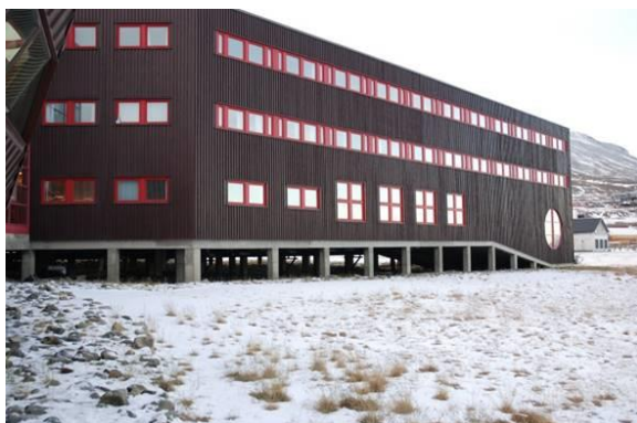
Figur 10. Fundamentering av UNIS på betongpilarer som er satt på betongsåle mer enn 1 m ned i permafrosten (prinsippskisse fra Andersland and Ladanyi 2004, figur 7-8. Foto J. O. Larsen).
