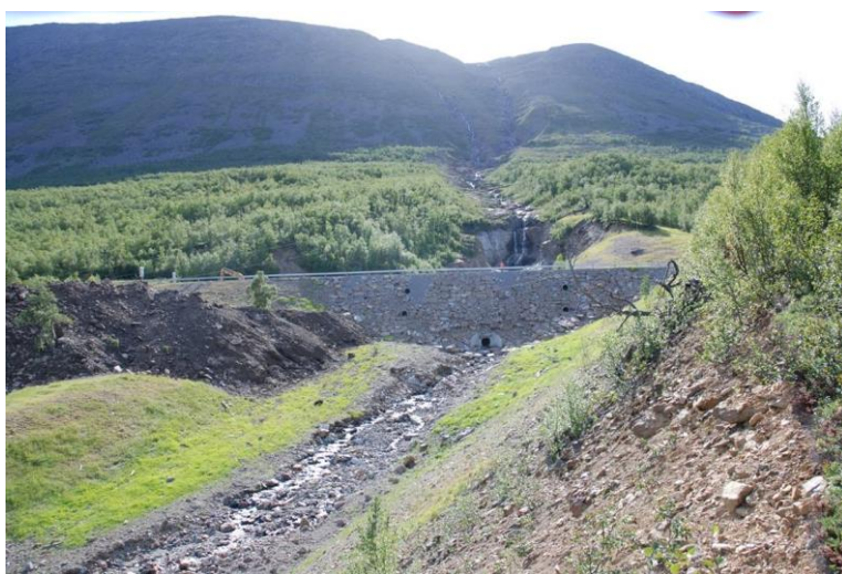
Figur 46. E6 på Herranes i Alta kommune er lagt på fangvoll mot sørpeskred med drenering i flere høyder for å unngå at vollen tiltaket blir et vannmagasin (foto J. O. Larsen).
