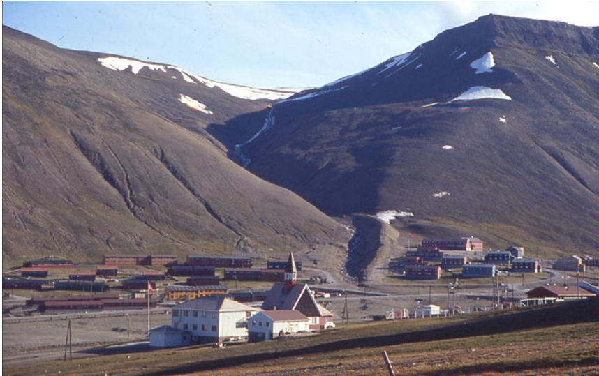
Figur 60. Haugen boligfelt beskyttet med en 17 m høy ledevoll (foto J. O. Larsen).
