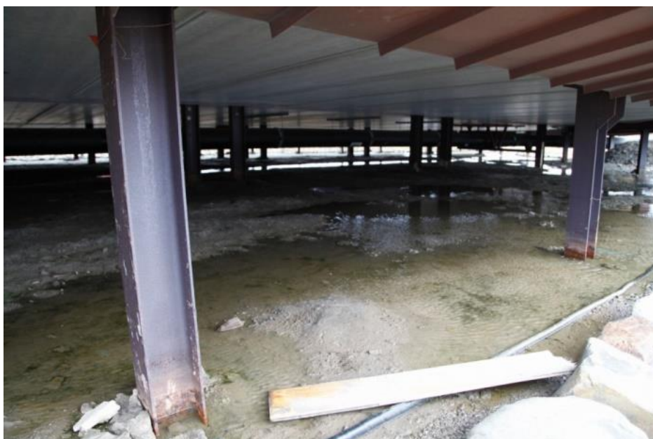
Figur 7. Stålpeler av 15 m lengde ble brukt i fundamentering av den nye Forskningsparken (UNIS) som ble ferdig i 2006 (foto J. O. Larsen).
