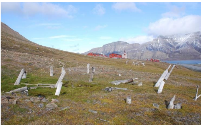
Figur 24. Gamle peler i den tidligere bebyggelse i Longyearbyen som alle står skjevt etter påvirkning av sig i det slake terrenget som kun har ca. 10° - 15° helling (foto J. O. Larsen).
