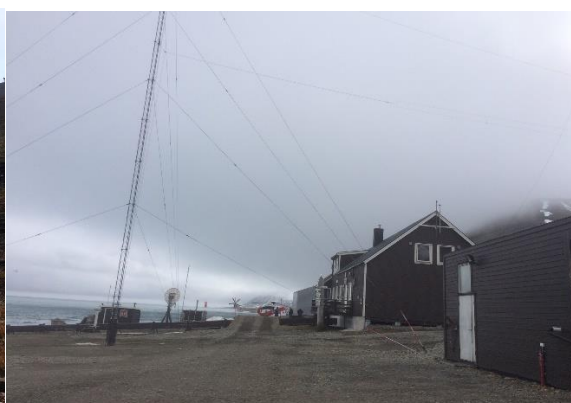
Branntilsyn på Hopen stasjon, vår 2016.
