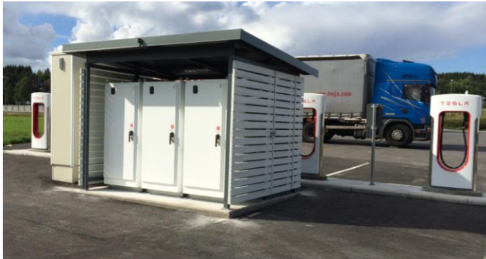
Figur 3 Ferdig montert klimabygg rundt superladere
