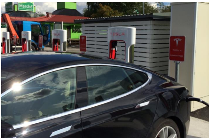
Figur 5 Klimabygg, fordelingsskap og ladestolper sett forfra
