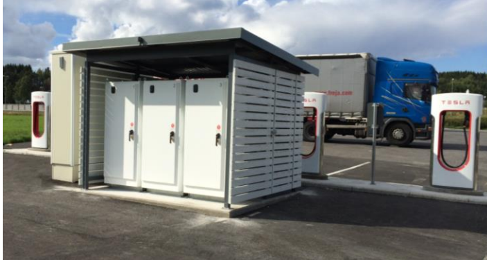
Figur 3 Ferdig montert klimabygg rundt superladere
