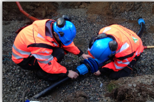
Arbeid på vannledning.
