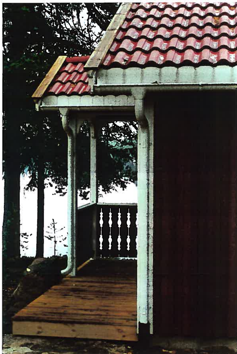
Fig. 35: Nyoppusset hytte, med nytt fortak over inngangen, forsiret gelender og nye takmaterialer. Denne byggeskikken kan i og for seg være pen, men er fremmed på Skjervetråkket og har ikke noe felles med tradisjonen der.
