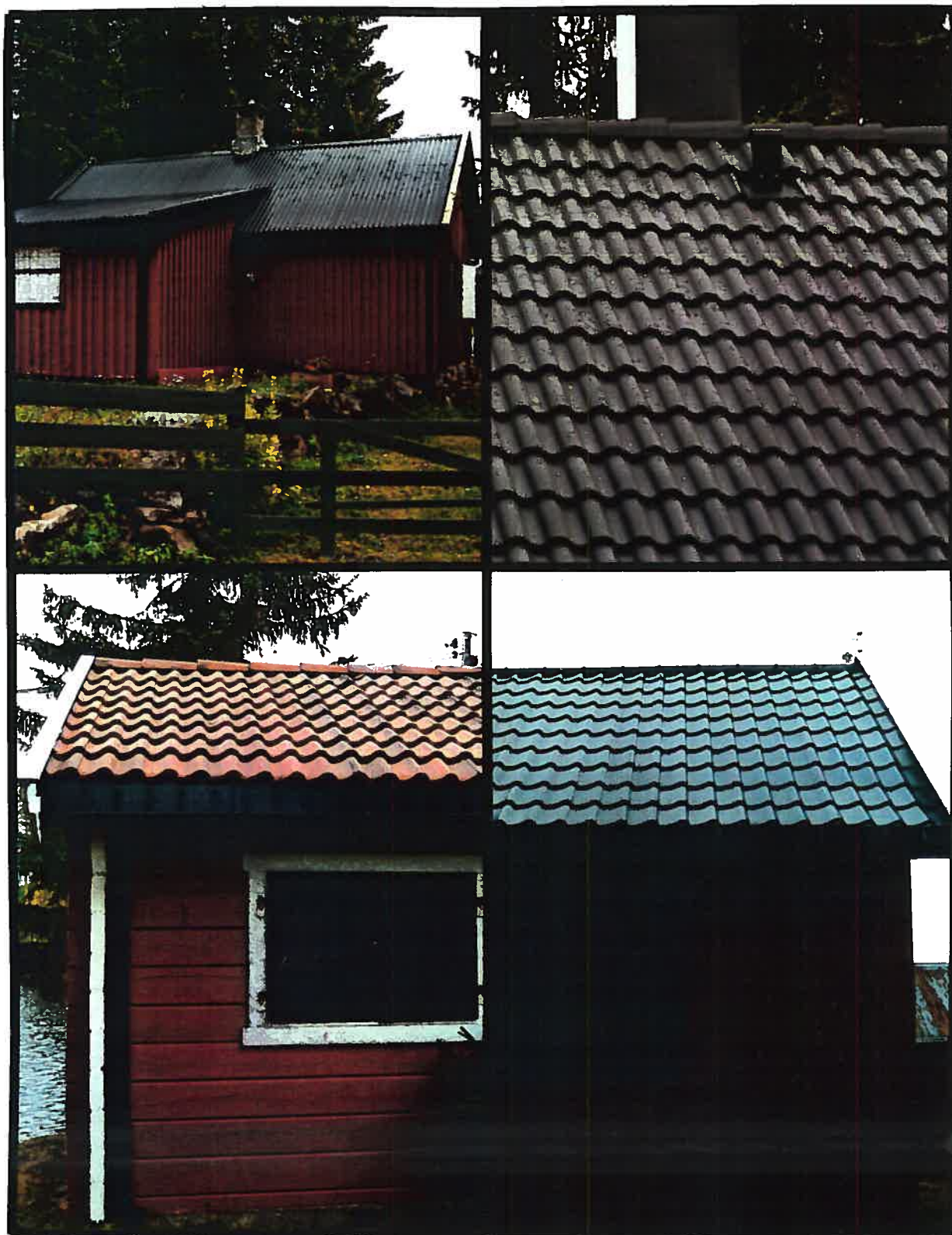
Fig. 29: Moderne og nye materialer som står i skjemmende kontrast til de tradisjonelle materialer. Øverst til venstre: svarte metallplater med skinnende overflate. Øverst høyre: Ny gråsvart sement-takstein, ny pipe med blikkforkledning virker fremmed Nederst venstre: Dobbelkrummet rød sement-takstein som erstatning for krummet takstein; et kompromiss. Nederst høyre: Stålplater med takstein-profilering og skinnende overflate. Med nytt tak kommer ofte også takrenner på bygningen, noe som forandrer huset enda mer.
