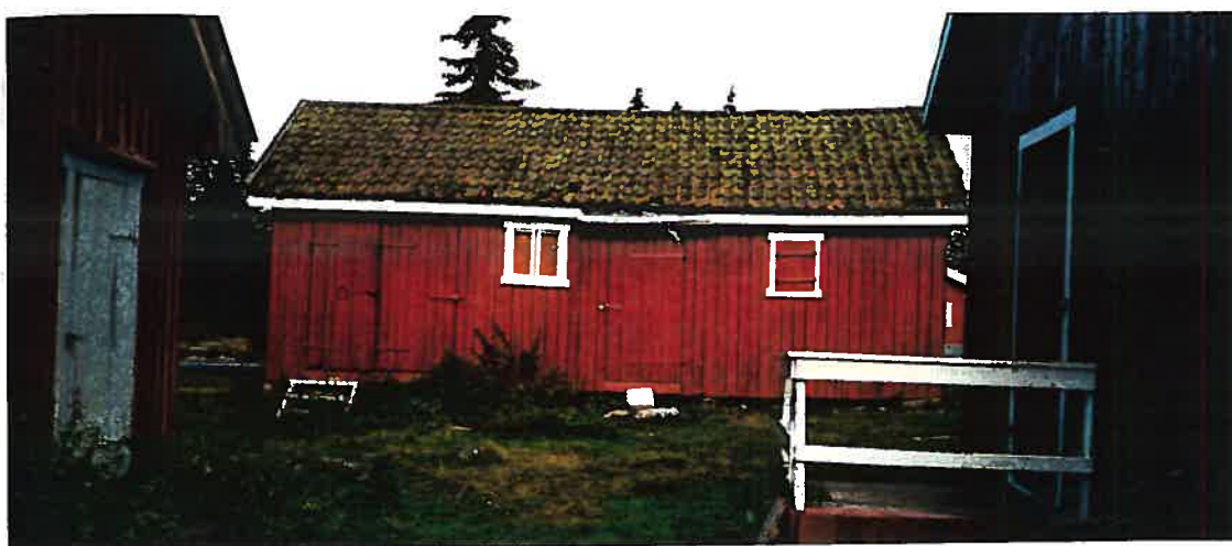
Fig.21: Bygning nr. 23. Eksempel på 2 staller, nesten uforandret. Takstein er muligens lagt på senere på toppen av flistaket.
