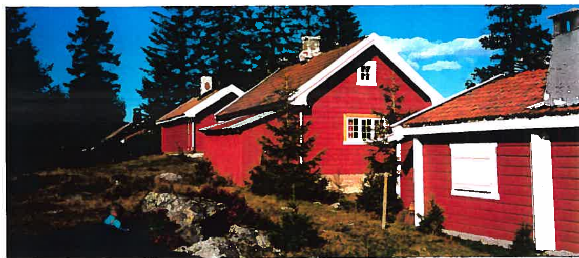
Fig. 15: Bygning nr.4, 3, 2, hytter i maskinlftet tømmerforholdsvis lite forandret, lik fargesetting understreker homogeniteten
