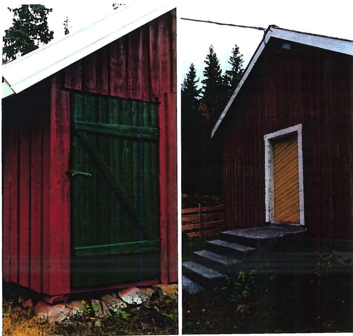
Fig. 34: Venstre: typisk labankdør til en stall. Høyre: panelt dør, mest utbredt er stående panel eller fiskebenmønster. Betongtrappa må være en "resirkulert" bygningsdel flyttet fra et annet sted.
