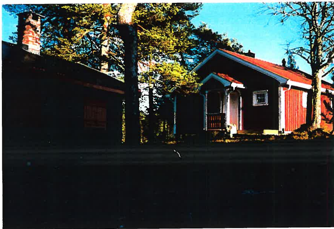
Fig. 12: Bygn. nr. 10, nylig utvidet hytte slik at opprinnelig bygningskropp og takvinkel ikke kan gjenkjennes. Mange nye detaljer, som liggende panel i gavlen, forsiret inngangsparti etc. Eksempel på at en "pen" oppussing av en hytte i sum kan føre til noe helt annet enn det som sto der opprinnelig.
