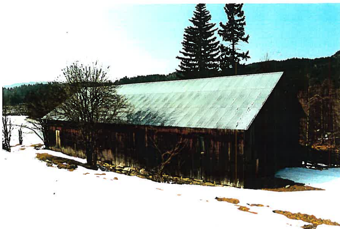
Fig. 7: Saghuset, byggeår ukjent, opprustet/ombygget i 1913. Selv om bygningen ikke er i bruk idag, så gir den dominerende bygningskroppen et signal om at det var et sagbruk her. Under bølgeblikkplattene ligger et gammelt bordtak. Opprinnelige dører, innganger og vinduer er lukket med panel
