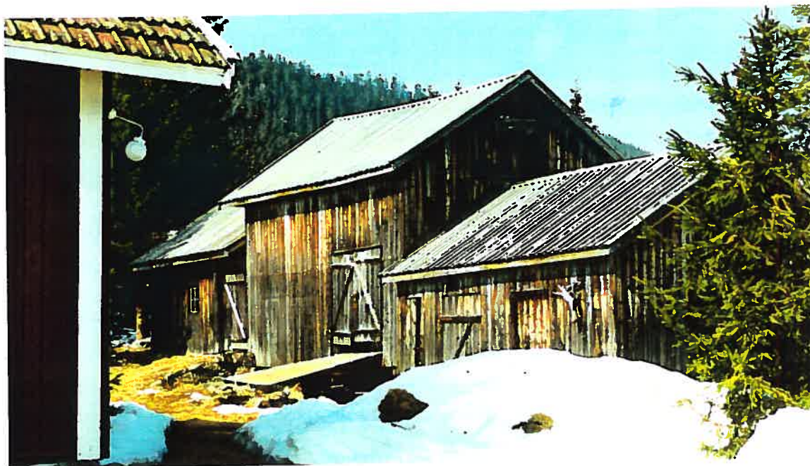
Fig. 5: Kjørestuas uthus (nr. 49), vedskjul, låve, fjøs, utedo. Sammen med kjørestua et markert bygningsmiljø, bevart i sin opprinnelige tilstand. Bordtak fornyet.
