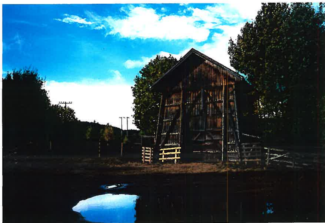
Fig. 8: Flishuset, bygget i 1950-årene med utvendig bindingsverk (det gamle stod nærmere dammen)
