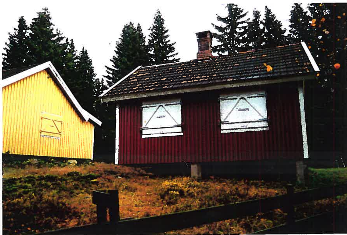
Fig. 25: Til venstre bygn. nr. 21, til høyre bygn. nr. 20. Begge hytter godt bevart, antagligvis bygget etter 1940.
