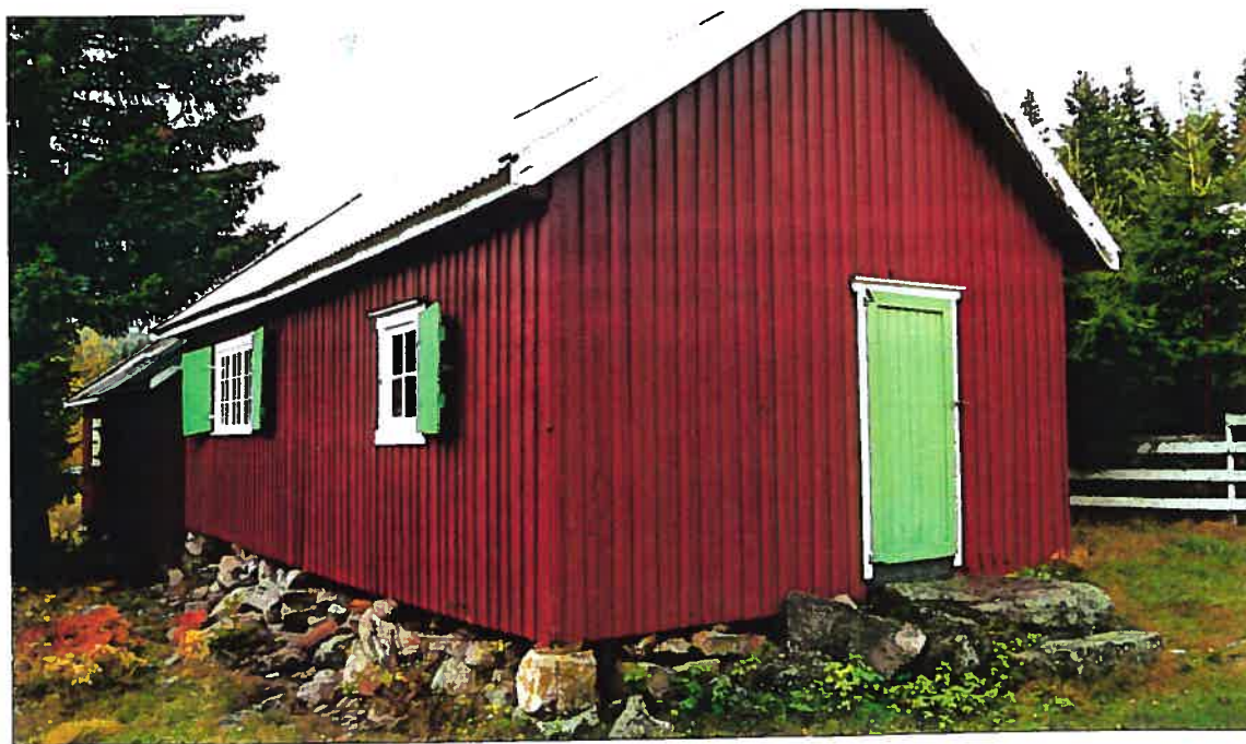
Fig. 31: Enkelt natursteinfundament, typisk og sjarmerende (bygn. 37)
