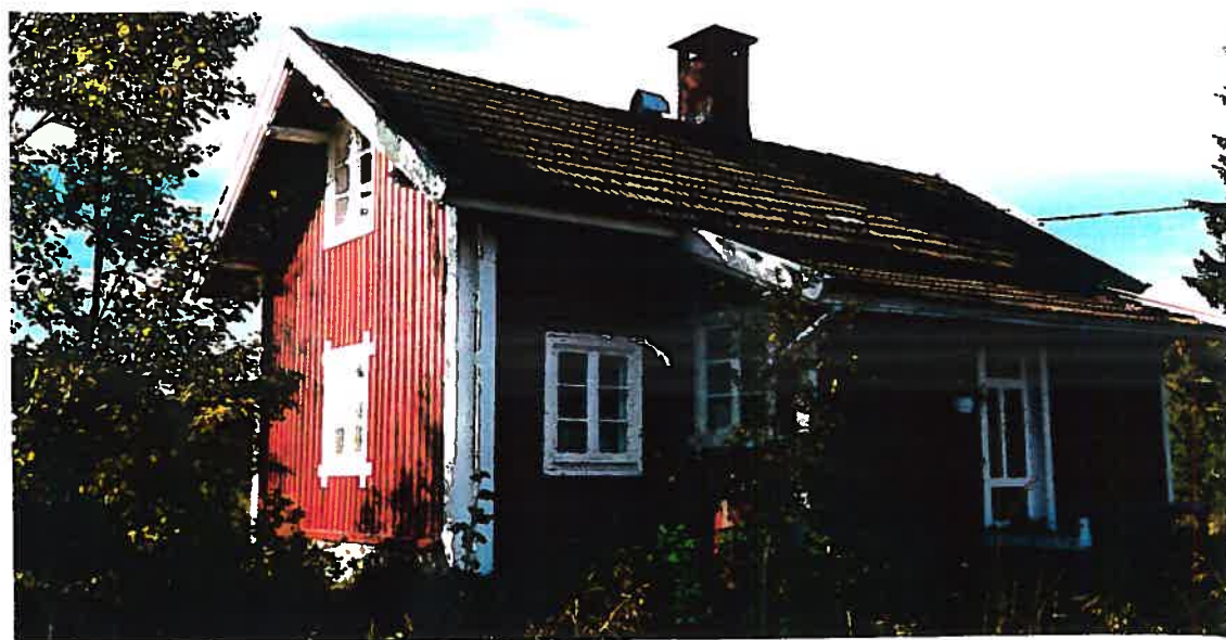
Fig. 18: Bygning Gnr.Bnr.52/5, kvernstuen, trolig fra 1800-tallet, fasade med stilelementer fra tidlig 1900-tallet. Antageligvis var det et bolighus tilknyttet kvernbruket, som en gang var drevet sammen med sagbruket. Eiendommen senere fraskilt fra sagbruket.
