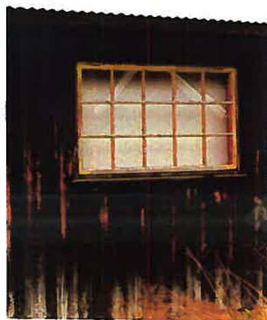
Fig. 38: Nye vinduer, med mindre og større avvik fra den lokale byggeskikken: a) nytt vindu av tradisjonell type, men omramming mangler, b) lite vindu, nytt, med spesielle omrammingsprofiler, litt for "pent", c) stort, horisontal preget format uten omramming, helt fremmed i byggeskikken
