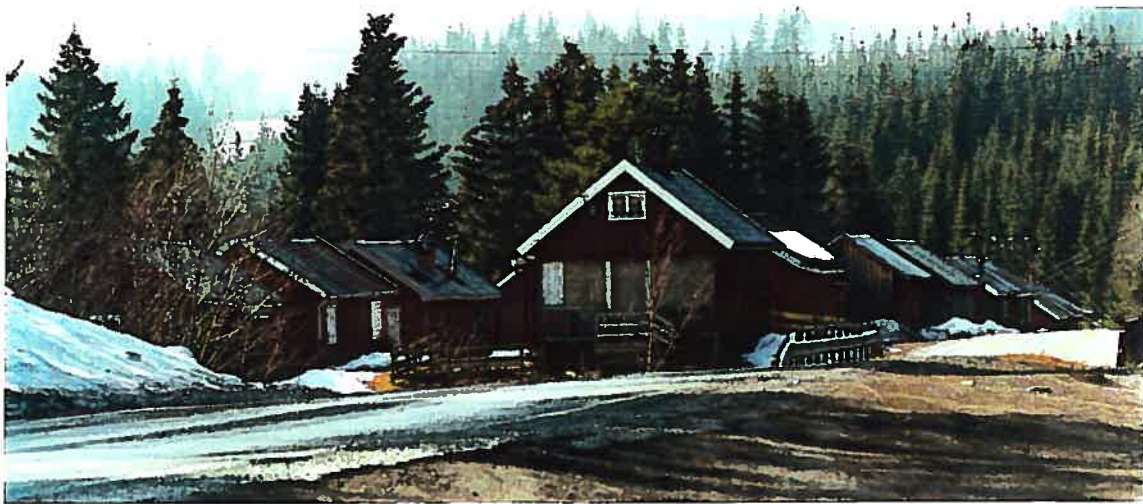
Fig. 27: Saltak med samme takvinkel preger bebyggelsen på sørsiden av veien.
