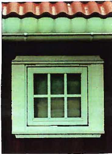
Fig. 38: Nye vinduer, med mindre og større avvik fra den lokale byggeskikken: a) nytt vindu av tradisjonell type, men omramming mangler, b) lite vindu, nytt, med spesielle omrammingsprofiler, litt for "pent", c) stort, horisontal preget format uten omramming, helt fremmed i byggeskikken
