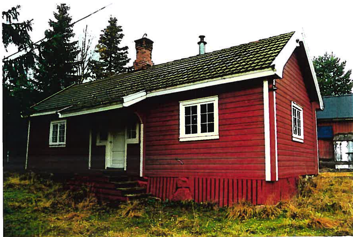
Fig. 6: Sagstua (nr. 51), bygget antageligvis rundt 1940-årene, maskinlaftet. Bolig/oppholdssted for almenningens arbeidere og driftsleder på saga. Godt bevart i sin opprinnelige form og detaljering, også innvendig.
