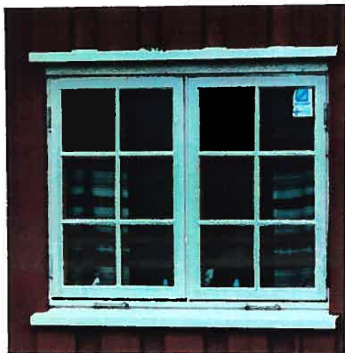
Fig. 38: Nye vinduer, med mindre og større avvik fra den lokale byggeskikken: a) nytt vindu av tradisjonell type, men omramming mangler, b) lite vindu, nytt, med spesielle omrammingsprofiler, litt for "pent", c) stort, horisontal preget format uten omramming, helt fremmed i byggeskikken
