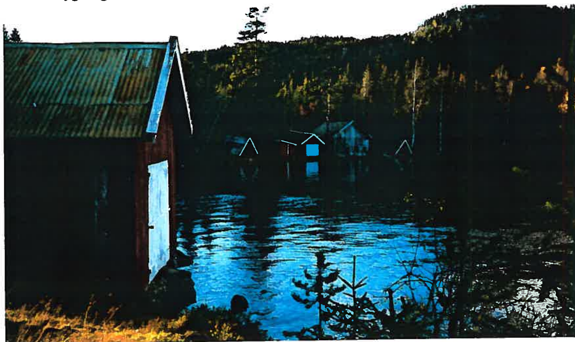
Fig. 9: Båthusene. I forgrunnen på venstre side bygning nr. 57, tilhørende hytte nr.11. I bakgrunnen en båthusrekke, preget av variasjon.
