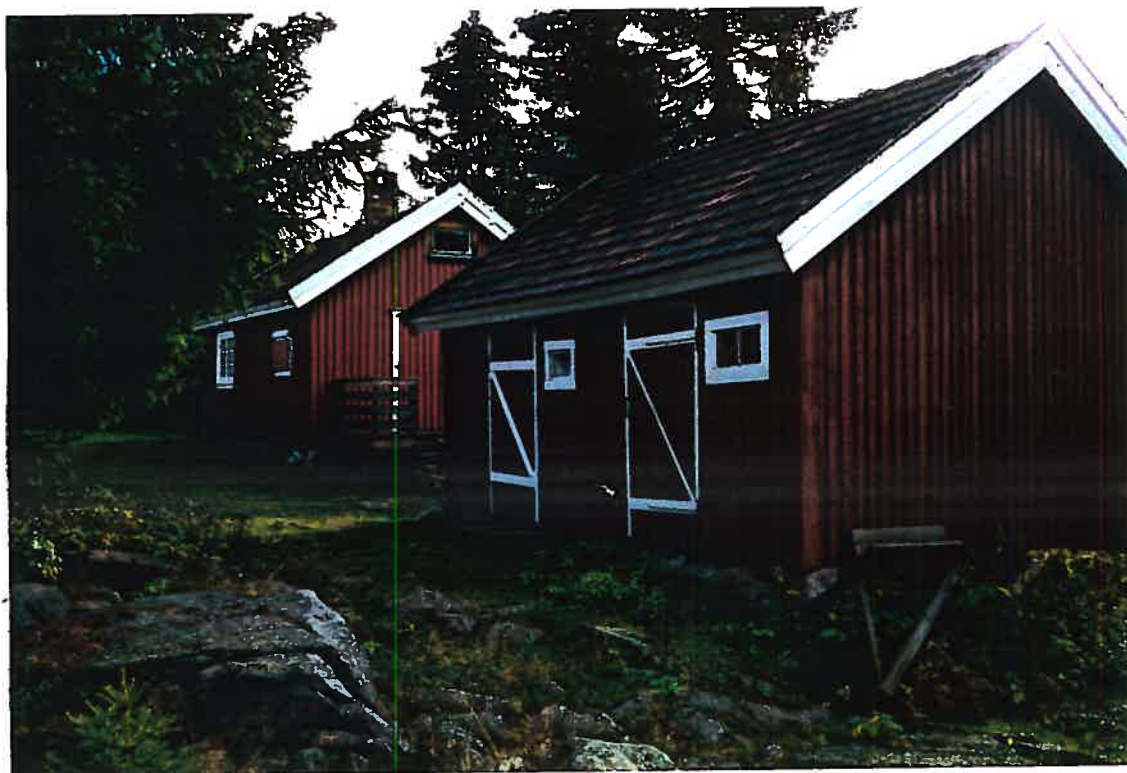
Fig.23: Bygn. nr.38 til venstre (bygget i 1937), bygn. nr. 50 til høyre; hytte og stall. Stort sett bevart i sin opprinnelig form og detaljering.
