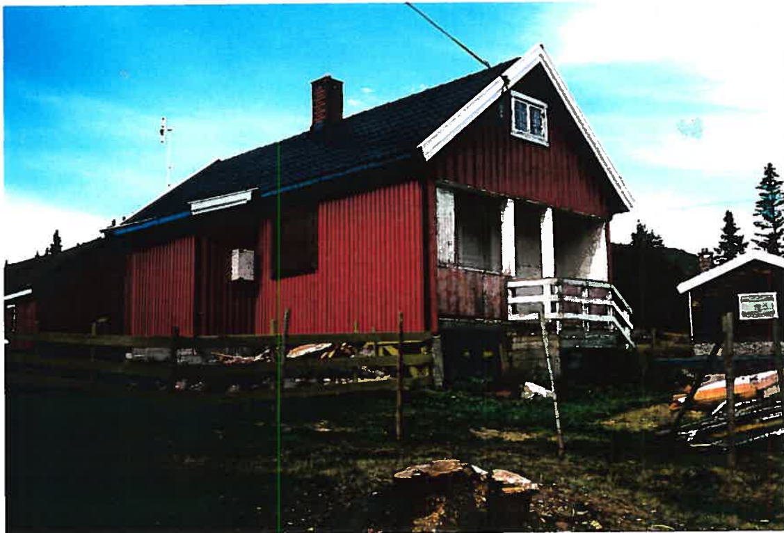
Fig.22: Bygning nr.22. Oppusset hytte, har pga. moderne taktekkingsmateriale mistet noe av sitt opprinnelige preg.
