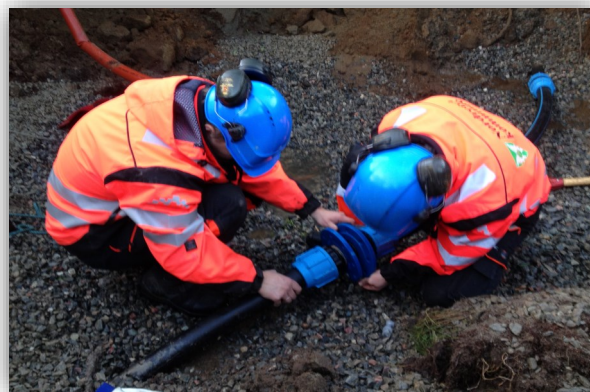
Arbeid på vannledning.
