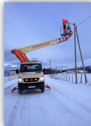
Utskifting av veglyspærer
