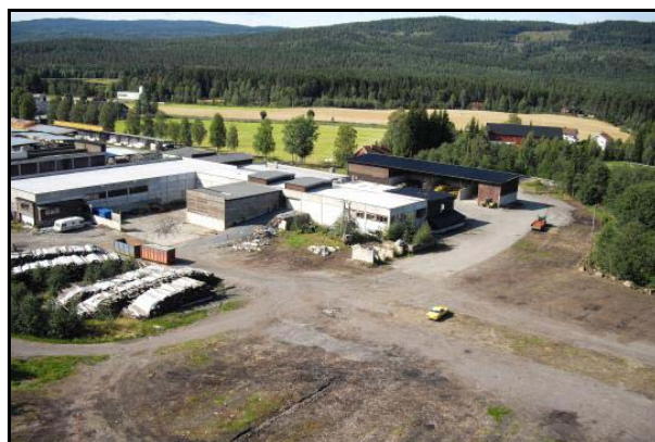
Sag - og høvleritomta, sett fra nordøst
