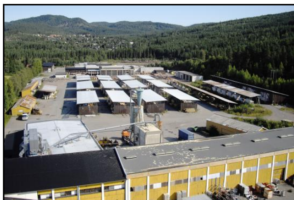
Sag - og høvleritomta, sett fra sør
