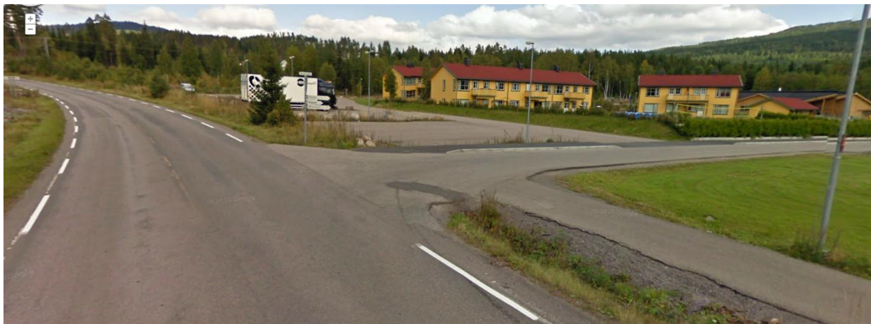
Kryss mellom Hadelandsvegen og Skolevegen er oversiktlig men mangler fotgjengerovergang – Bebyggelsen i B1 og B2
