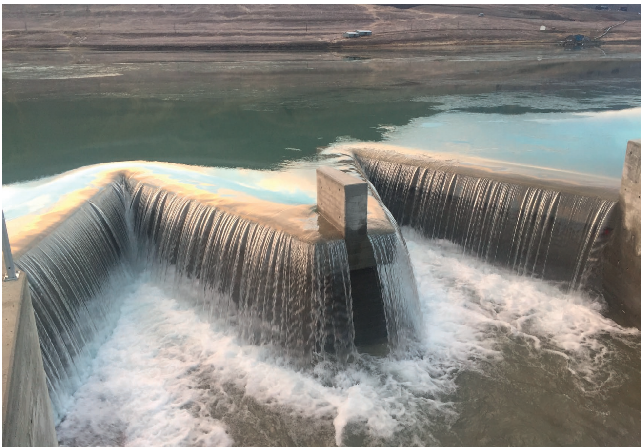
Nytt overløp Isdammen ferdig. Foto: Marius Larsen
