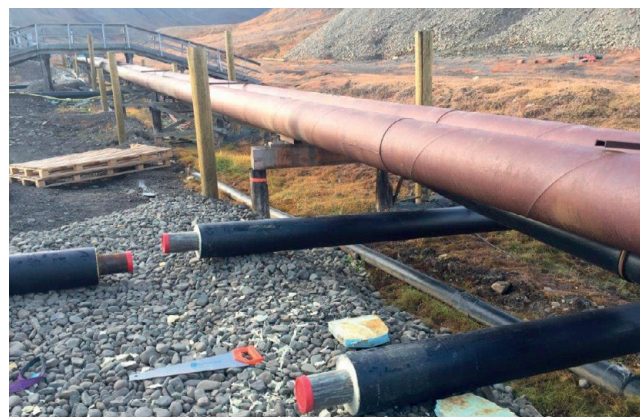
Bygging av nytt fyrhus (FH3) og fornying av rørbukker. Foto: Marius Larsen
