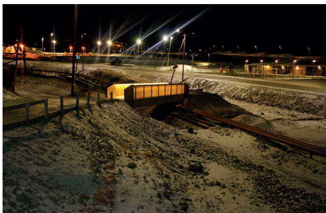
Ny gangbro på Haugen, nov. 2016. Foto: LNS
