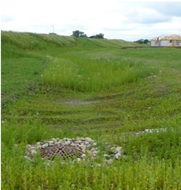
Nyanlagt vadi i forbindelse med veiprosjekt i Odense på leirjord. Ved ekstremregn ledes vannet via kuppelristen til drenerøret i bunnen av vadien. Foto: Orbicon.
