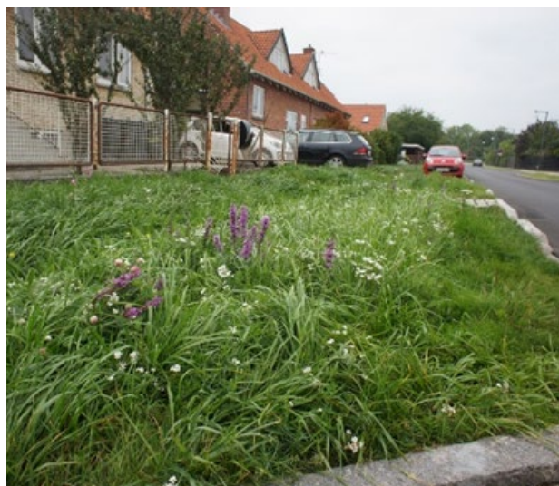
Vadi med underliggende dren med forsinket avledning til avløpsrør. Anlegget er dimensjonert til å magasinere ekstremregn lokalt og utgjør drøyt 30 % av veiens opprinnelige overflate (Rødovre Danmark). Foto: Orbicon
