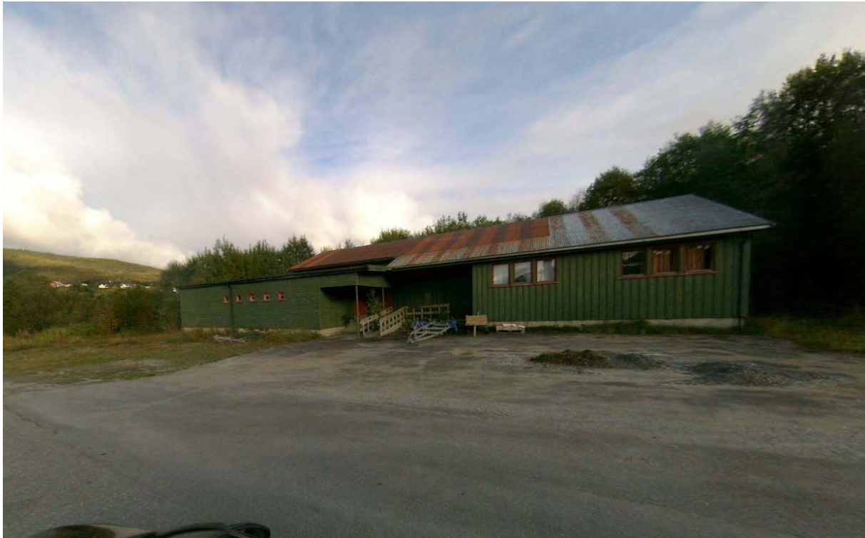
Bildet viser dagens idrettshus i planområdet ( http://www.safecontrol.no )
