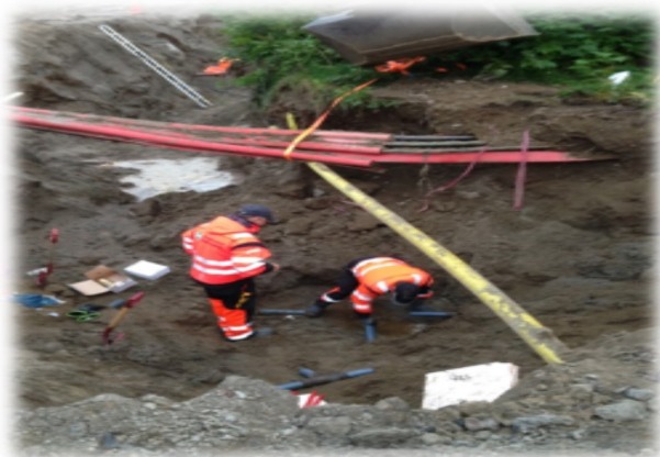
Montering av ny kum Arnestad
