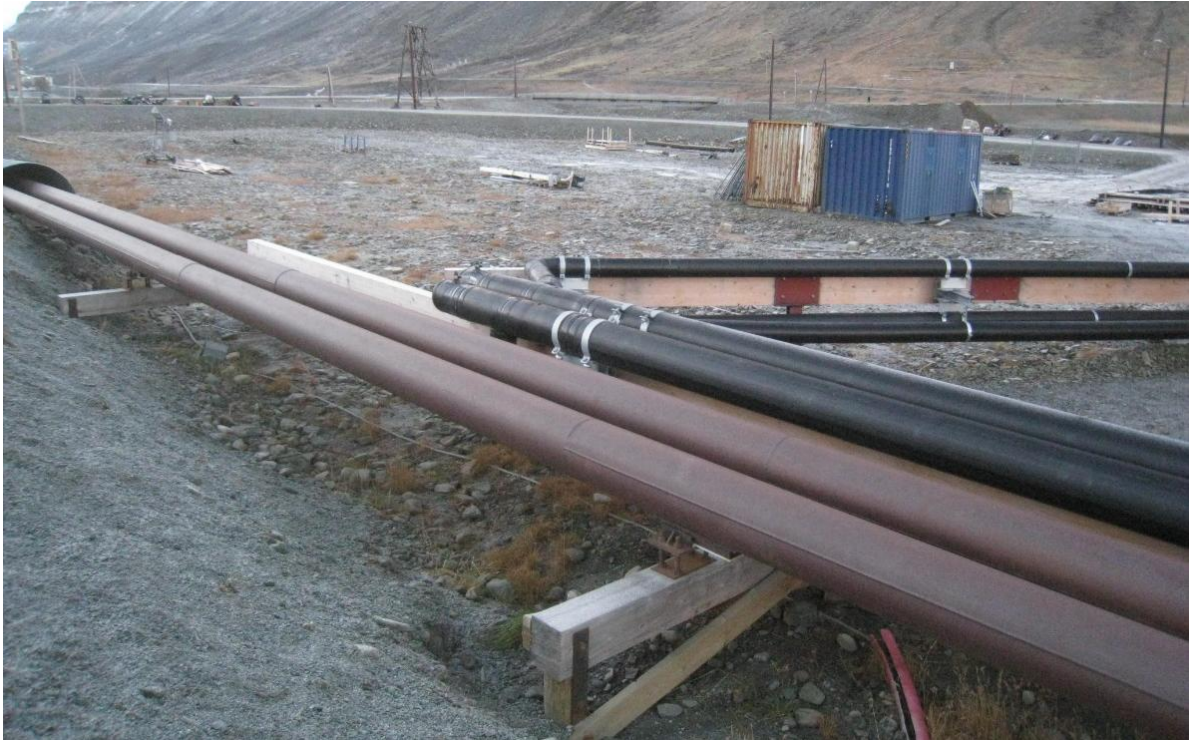
Figur 11: Fjernvarmerør langs veg 500
