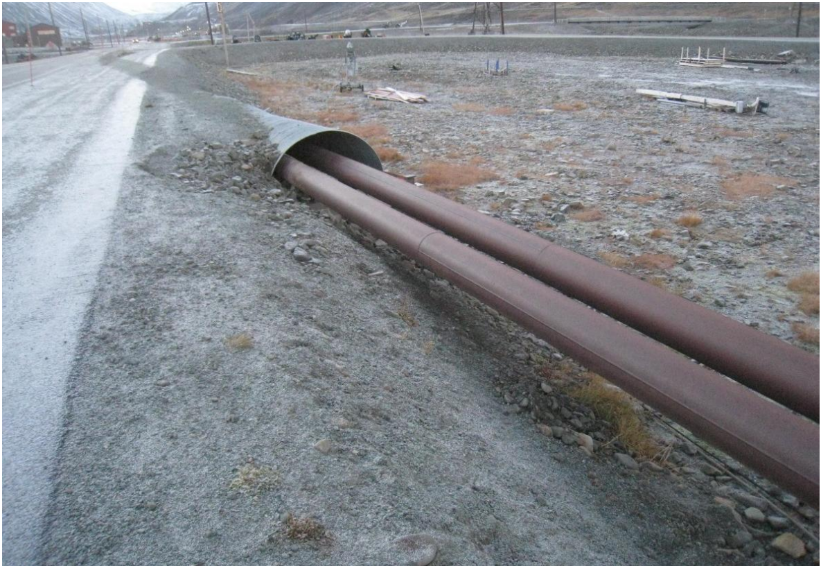
Figur 12: Fjernvarmerør ved kryssing av veg 500, nord for kryssing
