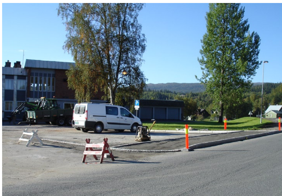
Området rundt rådhuset blir rustet opp i et stedsutviklingsprosjekt. Prosjektet er gitt 50% tilskudd fra Nordland fylkeskommune.
