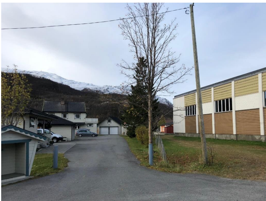
IX Svømmehallens fasade mot sør, hvor tomten grenser mot to eneboliger.
