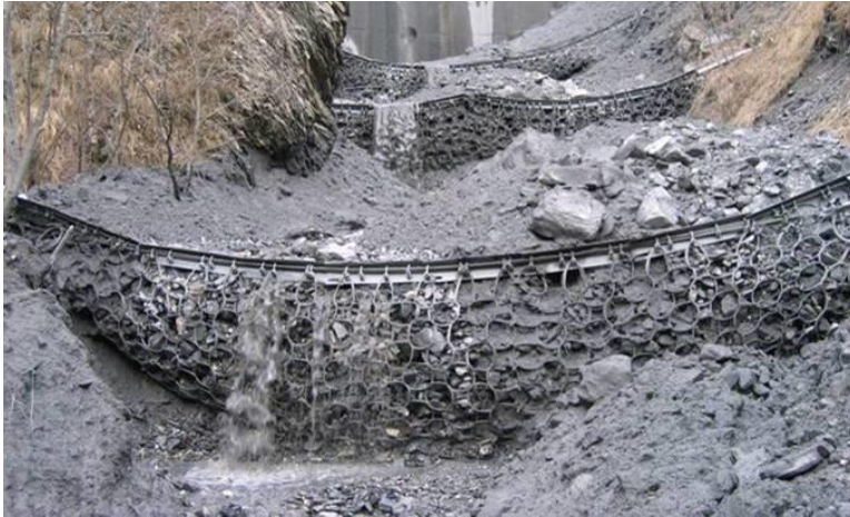
Figur 55. Effekten av nett som sikring mot flomskred (Corinna Wendeler, Geobrugg AG, 2013).
