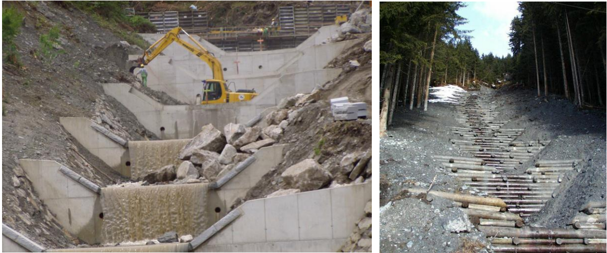
Figur 53. Sabo dammer i betong eller tømmer for å hindre erosjon og utløsning av flomskred i en elvedaler (Sauermoser S. 2013).
