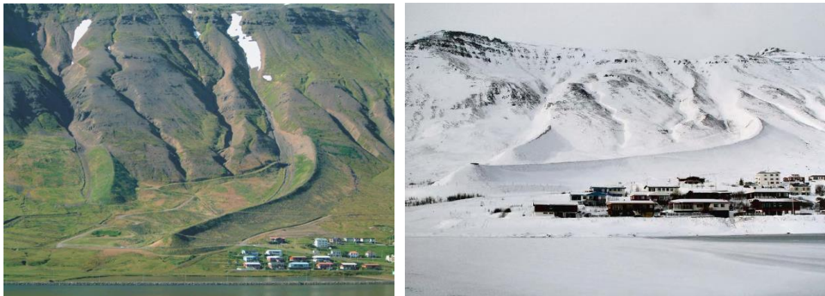
Figur 39. Ledevoll som skredsikring i Siglufjorður på Island (Landslag ehf. Landscape Architects Iceland).
