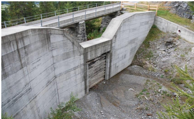
Figur 52. Fangdam for sørpe- og flomskred fra Davos i Sveits (foto J. O. Larsen).
