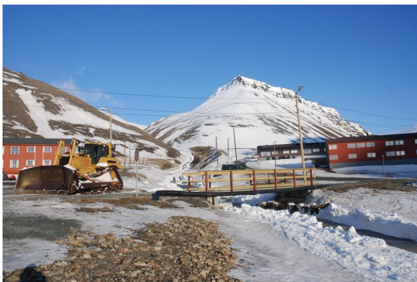
Figur 57. Bulldosere åpner Vannledningsdalen for å hindre utløsning av sørpeskred (foto J. O. Larsen).
