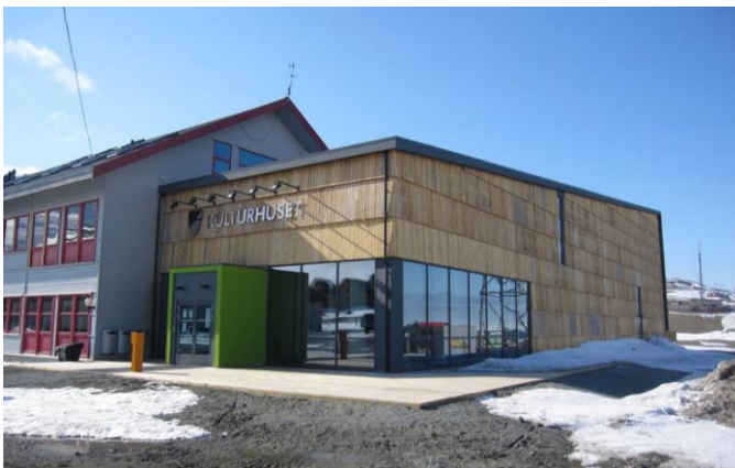
Figur 14. Kulturhuset i Longyearbyen på fryseelementer som holder konstant temperatur u fundamentet hele året (foto J. O. Larsen).
