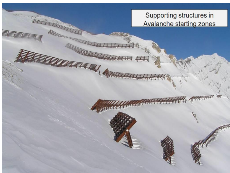
Figur 31. Stålforbygninger i Tyrol (foto Siegfried Sauermoser).
