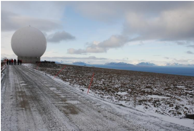
Figur 13. Radaranleggene på SVALSAT er fundamentert direkte på permafrost i fjell der det oppsprukne aktive laget i dagfjellet med frostlinser er fjernet før fundamentet ble støpt (foto J. O. Larsen).
