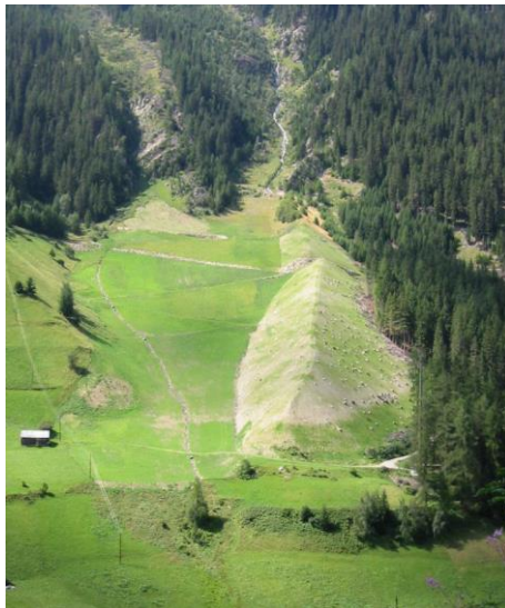
Figur 37. Ledevoll i løsmasser i Tyrol med skisse av utførelse (Sauermoser S. 2013).
