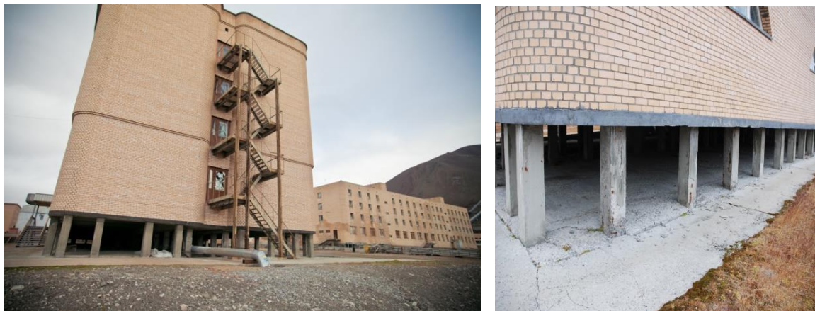
Figur 6. Betongpeler som fundament for Tulipan hotell i Pyramiden. Dessuten bruk av betongdekke mellom pelene for å unngå vanninntrengning i grunnen (foto J. O. Larsen).
