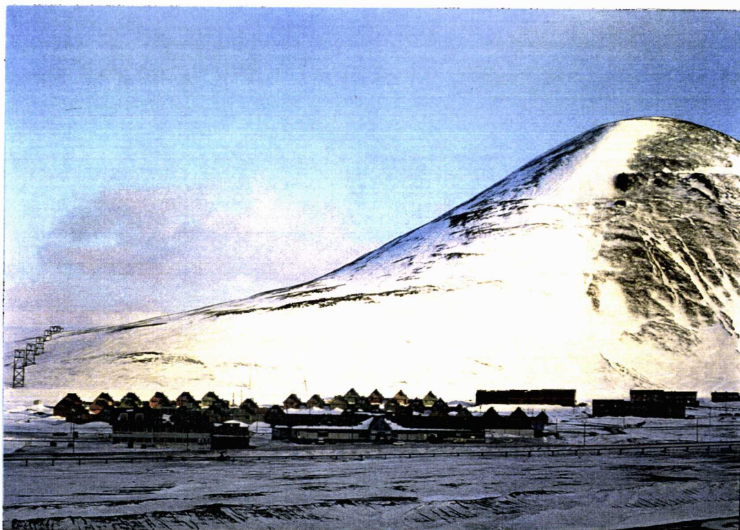
Foto 2 De potensielle løseområder for snøskred ovafor bebyggelsen i Veg 226-230. (Foto 24. april 1992.) Tippområdet ved Gruve 2 er godt synlig i fjellsida.
