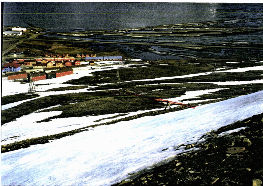
Foto 5 Det slakere partiet omkring foten av den NØ-vendte fjellsida til Gruvefjellet. Tilnærmet plassering av eventuell snøskjerm.
