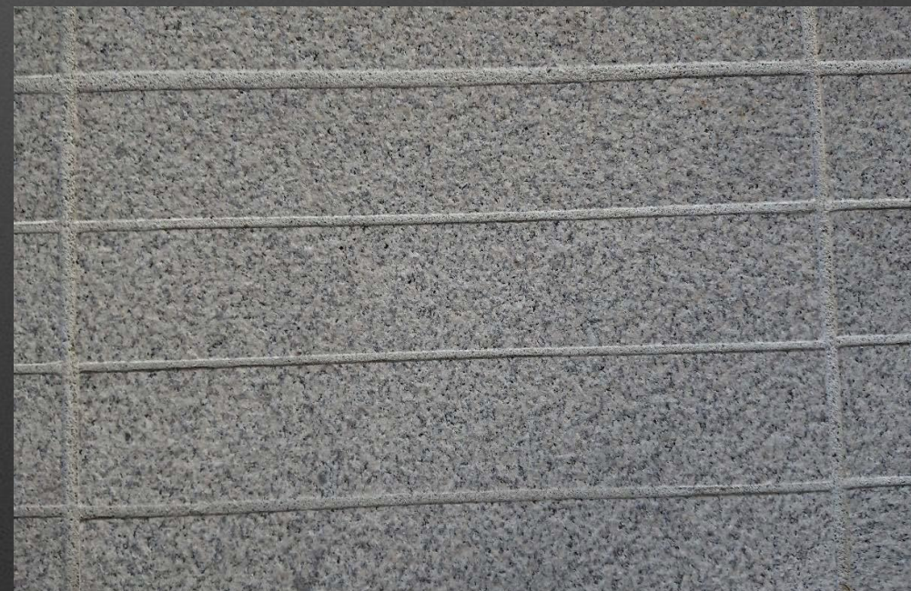
Nye Bergen terminal – liming og fugging av granitt – 2016 -2017
