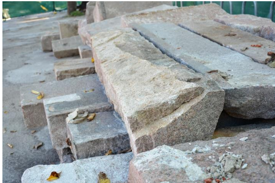
Trappetrinnene i granitt er lagret for ombruk utomhus
