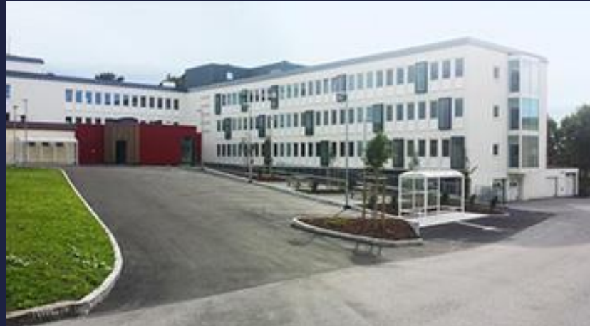
Aukra kommune - Omsorgssenter, nybygg, 50 rom, 2018
