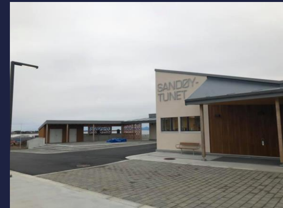
Sandøy kommune – Sandøytunet, rehabilitering, 10 rom, 2019
