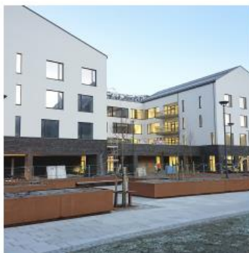
HELSEHUS. Rauma Helsehus får installert det nyeste innen velferdsteknologi. Foto: EL 24
