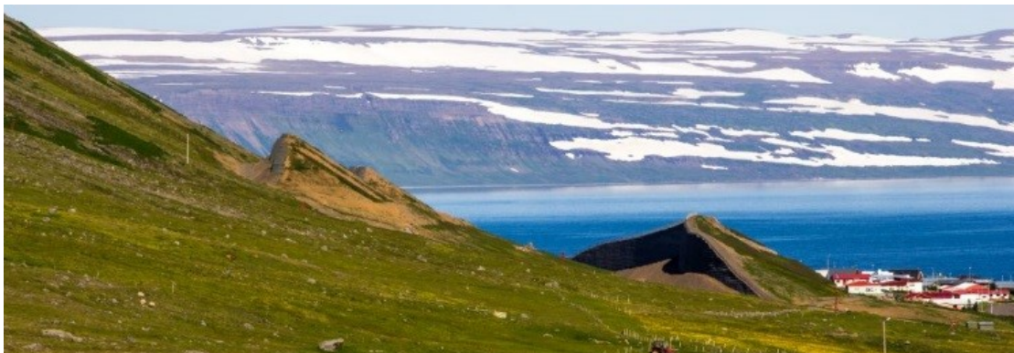
Figur 4-5. Eksempel på kjegler (til venstre) og fangvoll for snøskred (til høyre) med bratt støtside ovenfor bebyggelse i Bolungarvik, Island. Foto: Arni Jonsson.
