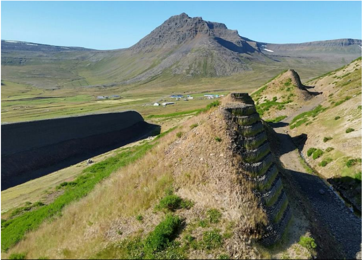
Figur 11. Bremskjegler kombinert med fangvoll på Island (NVE).
