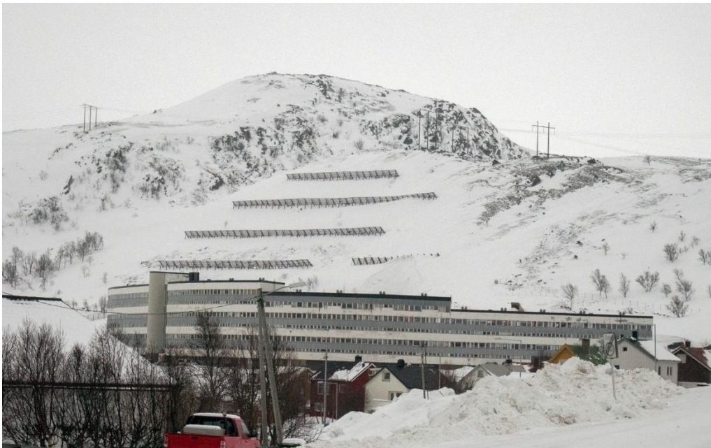
Figur 5: Støtteforbygninger av stive stålkonstruksjoner over Hesteskoblokka i Hammerfest. (Foto: NVE)
