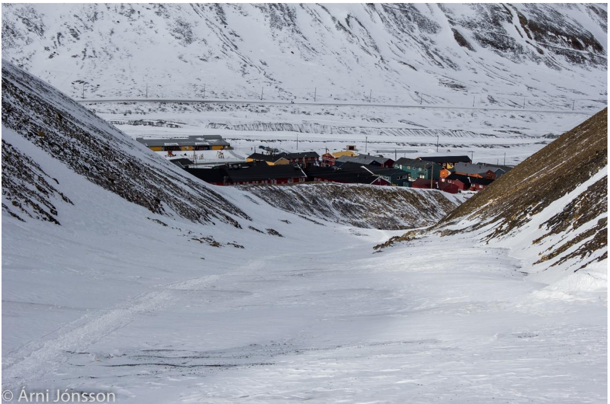
Figur 18. Nedre del av Vannledningsdalen, med ledevoll langs venstre bredd mot Haugen boligfelt.
