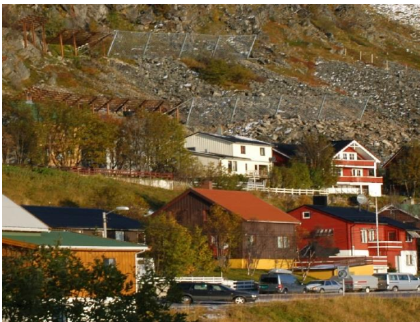
Figur 5: Støtteforbygninger av stive stålkonstruksjoner over Hesteskoblokka i Hammerfest. (Foto: NVE)
