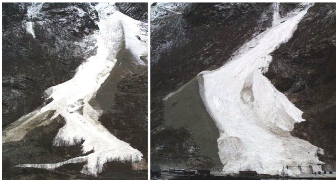
Figur 7. Ledevoller som sikringstiltak mot snøskred. (Foto: NVE)
