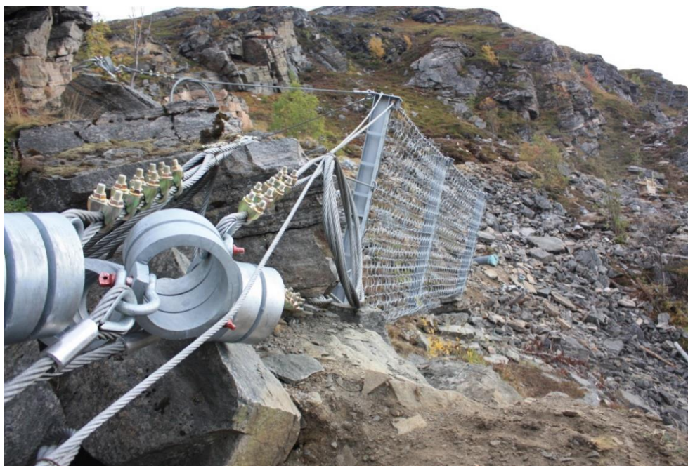
Figur 9. Illustrasjon av fangnett for sikring mot steinsprang og snø i Hammerfest (Foto: NVE).
