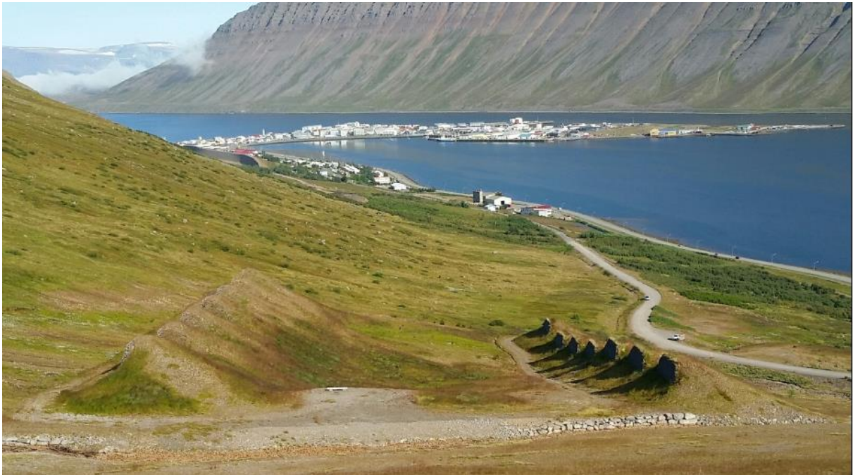
Figur 10. To rader med fangvoll på Island (NVE).
