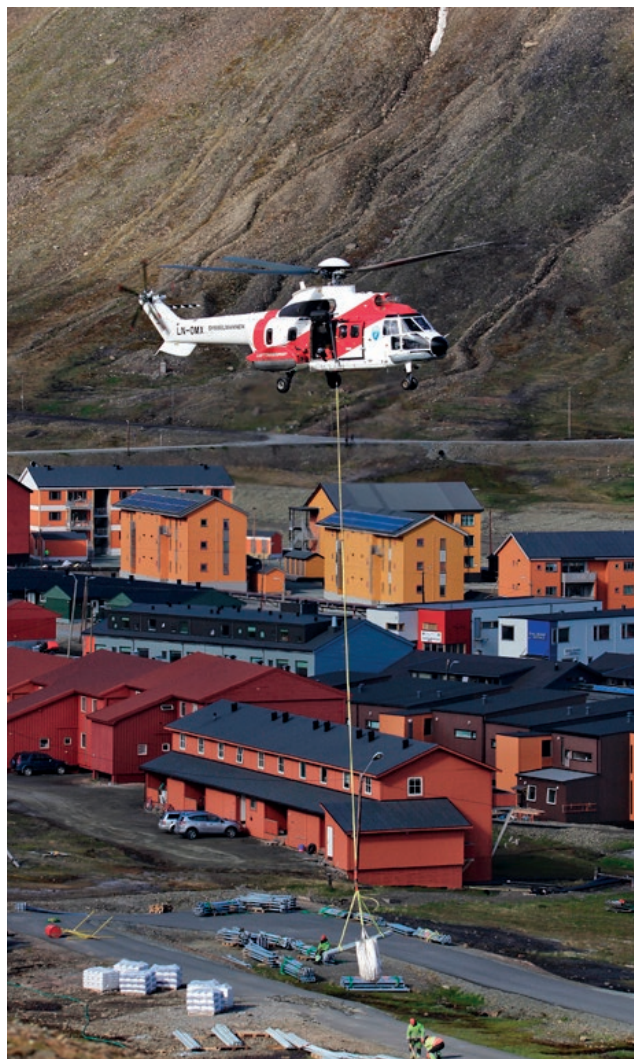
Helikoptertransport av byggemateriell til rassikring. Foto: Morten Dyrstad
