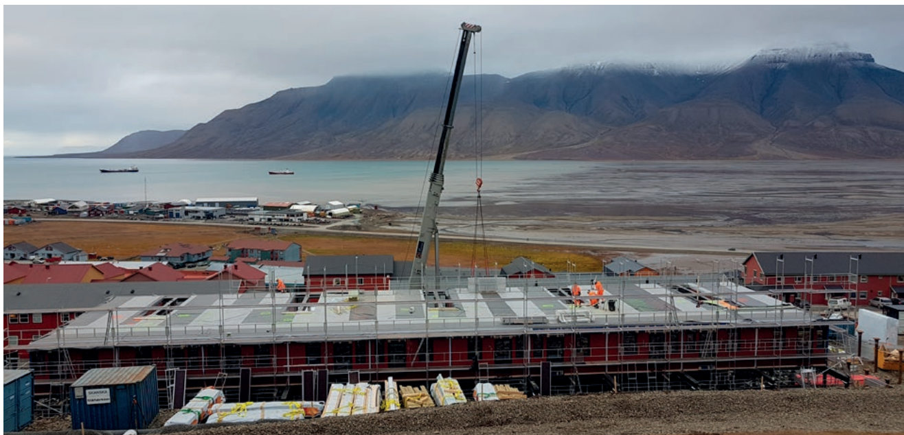
Bygging av nye boliger i Gruvedalen. Foto: Mona Ada Andersen
