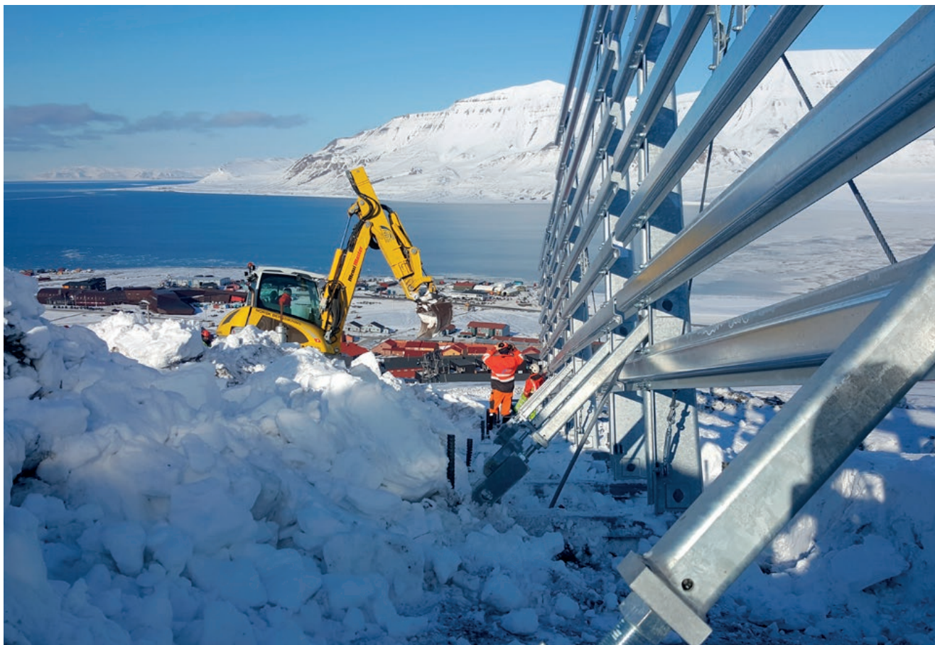
Montering av snøsamlerskjerm. Foto: Kjersti Olsen Ingerø
