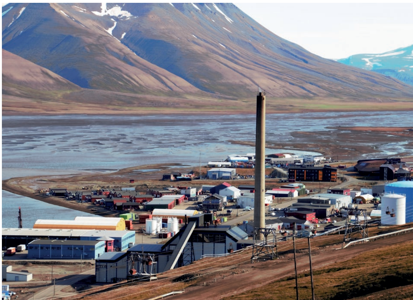
Energiverket og Sjøområdet. Foto: Jorunn T. Høiland
