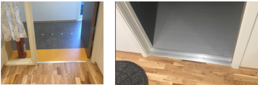
Trinnfrie terskler (lister) til boenhet og bad. Foto: Husbanken, Veileder for lokalisering og utforming av omsorgsbygg
