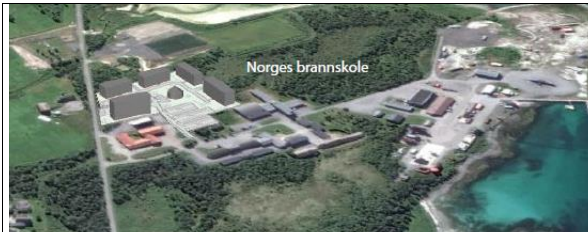
Se eget vedlegg nr.7 og 8. Bildet viser byggehøyde 6 etg. på hotellbygget.
