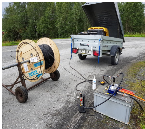
Montering av fiberkabel til abonnent
