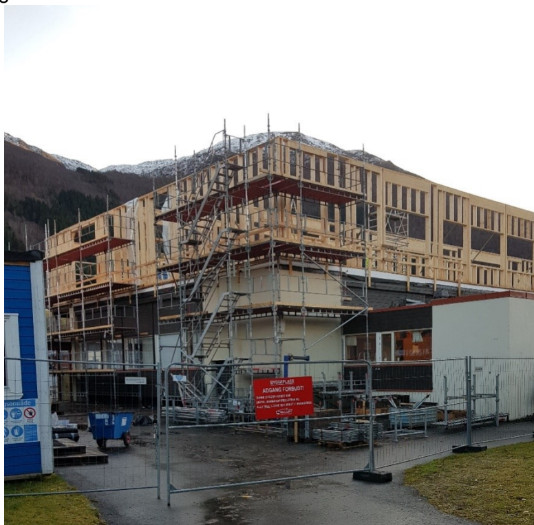
Bilde 3 Fotograf Birgit Eliassen, Batnfjord skule under renovering november 2019.
