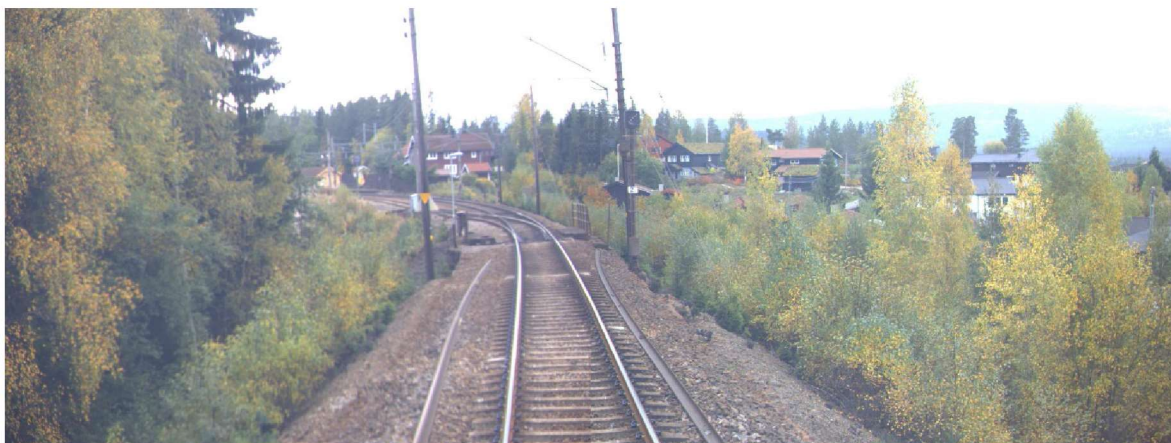
Figur 2-9. Sporveksel og bru ved Paradisvegen, km. ca. 44,23, sett fra nord mot sør. Boligbebyggelse i Furumo.
