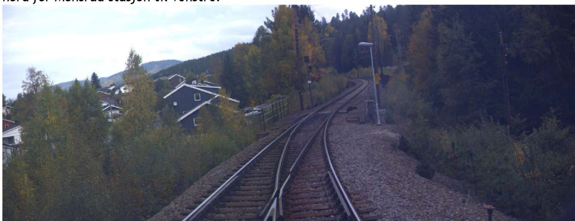
Figur 2-8. Sporveksel, signalanlegg og bru ved ved Paradisvegen, km. ca. 44,23, sett fra sør mot nord.
