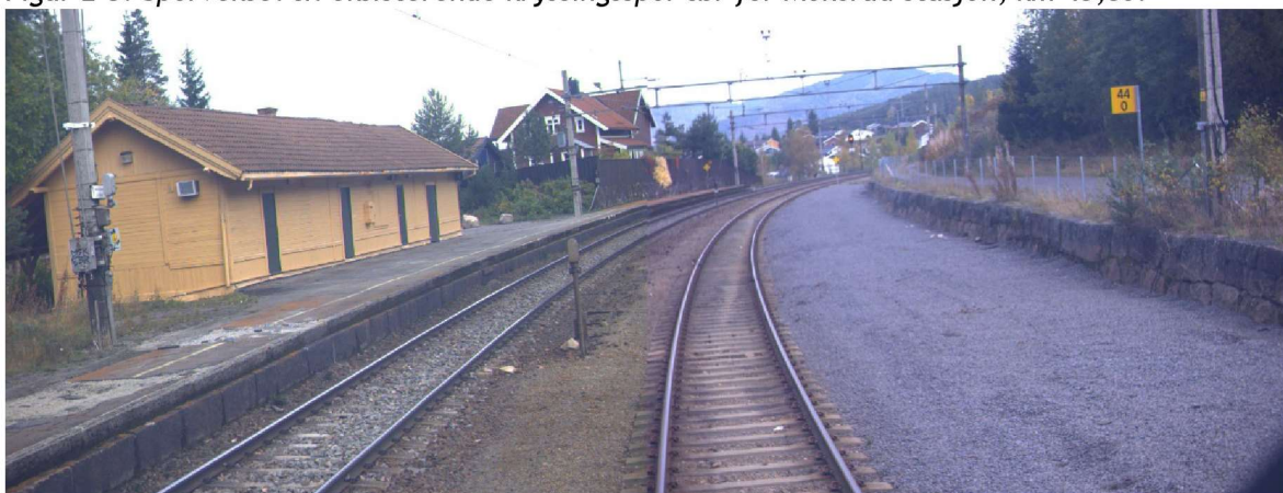
Figur 2-6. Monsrud stasjon, ca. km 44,00. Eksisterende avvikspor til høyre.
