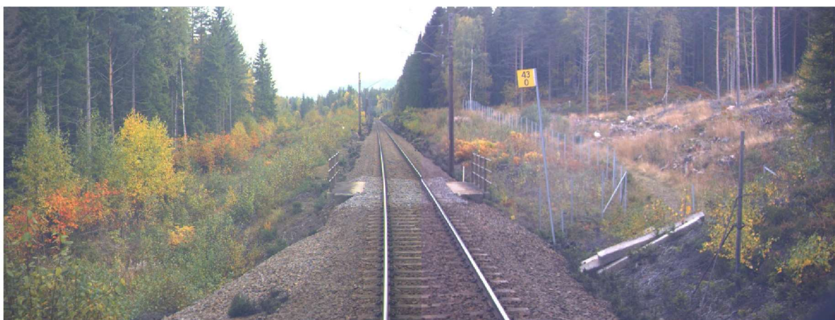
Figur 2-4. Bru for gangsti under banen ved km ca. 42,97 (Monsrud undergang). Sti vises til høyre for sporet. Rettstrekning km 43,02 - 43,54.
